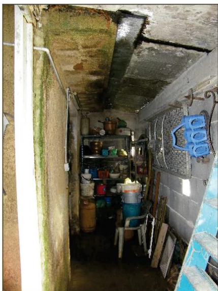
Foto 31. Magazzini edificati senza autorizzazione
