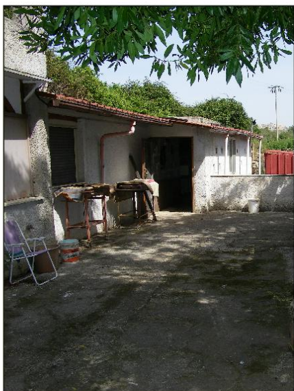
Foto 25. Magazzini edificati senza autorizzazione
