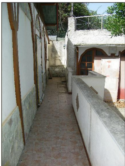
Foto 17. Balconata sul prospetto ovest
