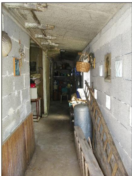
Foto 27. Magazzini edificati senza autorizzazione
