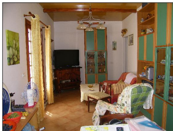
Foto 34. Veranda chiusa senza autorizzazione
