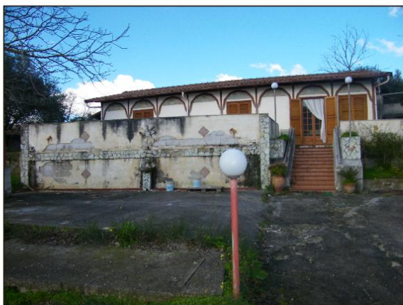
Foto 9. Prospetto principale della casa con scala d'accesso e terrazzo
