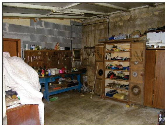
Foto 30. Magazzini edificati senza autorizzazione
