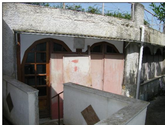
Foto 22. Ingresso al locale ricavato nella tettoia
