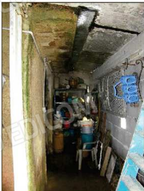
Foto 31. Magazzini edificati senza autorizzazione
