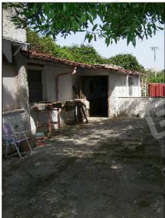
Foto 25. Magazzini edificati senza autorizzazione
