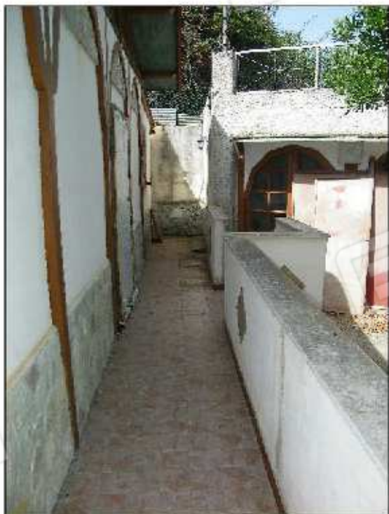
Foto 17. Balconata sul prospetto ovest
