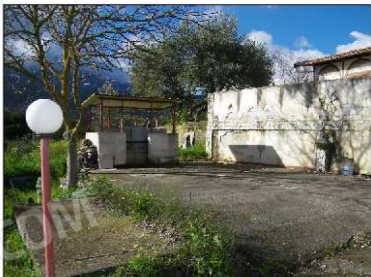
Foto 6. Tettoia di copertura del serbatoio di gpl per caldaia
