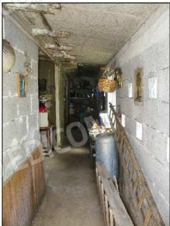
Foto 27. Magazzini edificati senza autorizzazione
