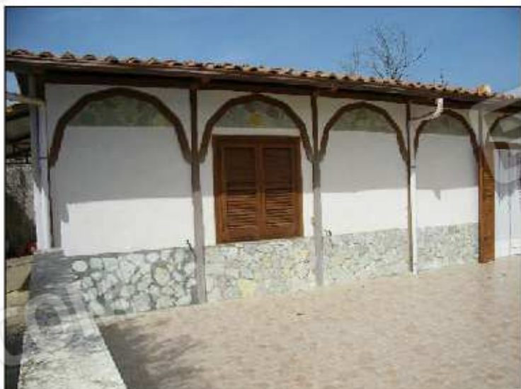
Foto 10. Particolare del prospetto principale
