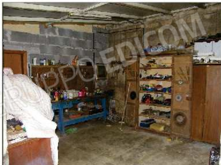
Foto 30. Magazzini edificati senza autorizzazione
