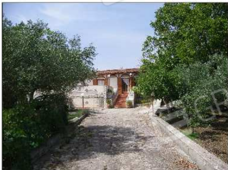
Foto 5. Scorcio della casa dal vialetto d'ingresso
