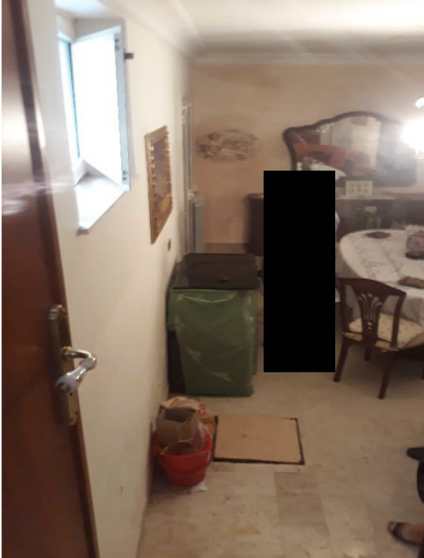
2. L'interno del piano terra, nel pavimento si nota la botola della cisterna interrata
