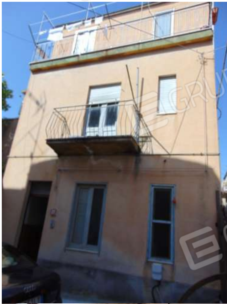
FOTO 03 - VISTA PROSPETTO DALL'AREA COMUNE
