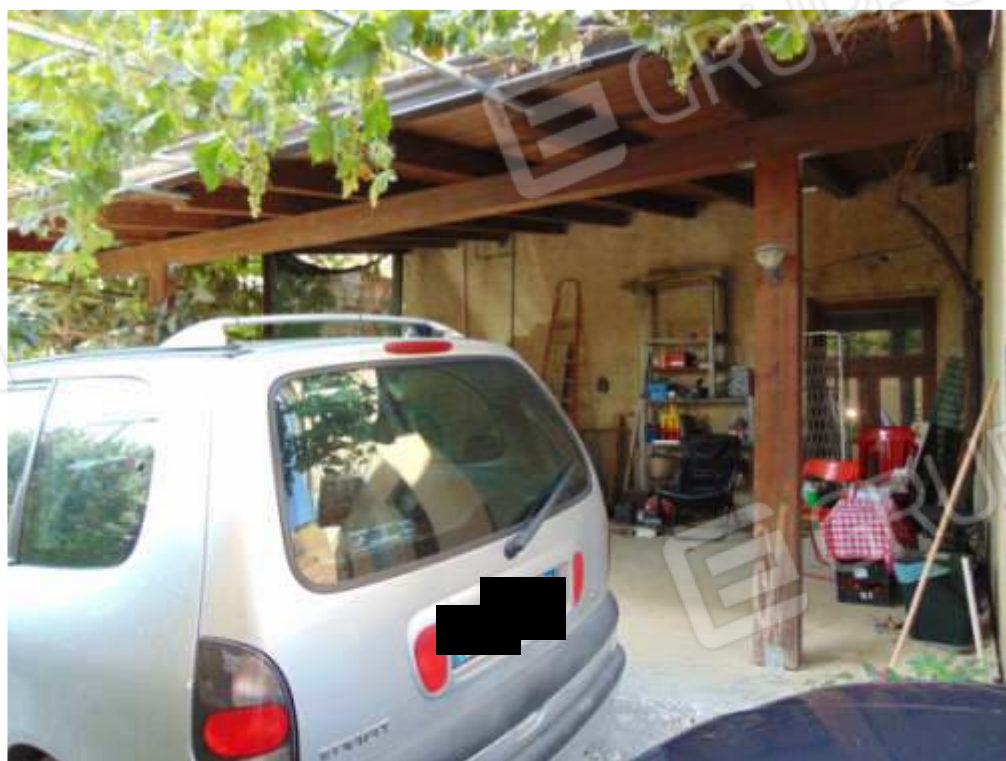
FOTO 04 - VISTA TETTOIA DI PERTINENZA DEL GARAGE
