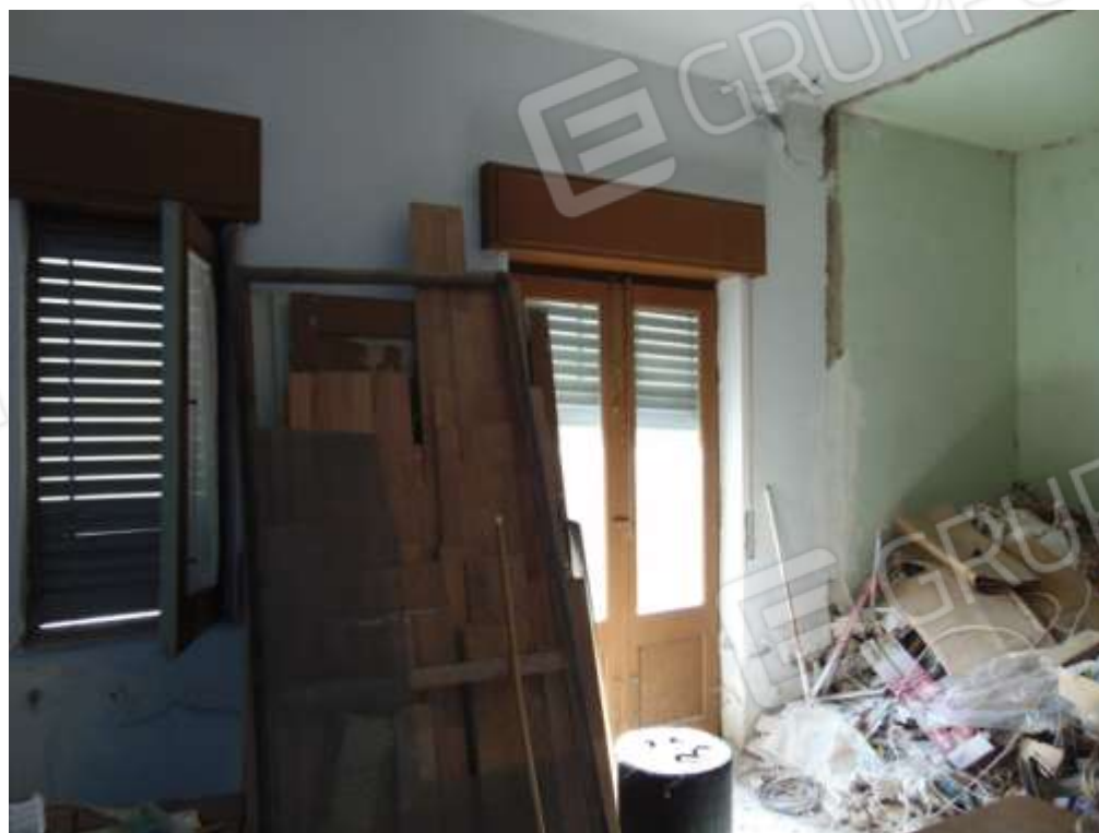
FOTO 04 - APPARTAMENTO 1° PIANO (LOTTO 2) soggiorno
