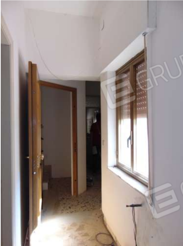
FOTO 01 - APPARTAMENTO 1° PIANO (LOTTO 2) ingresso e corridoio
