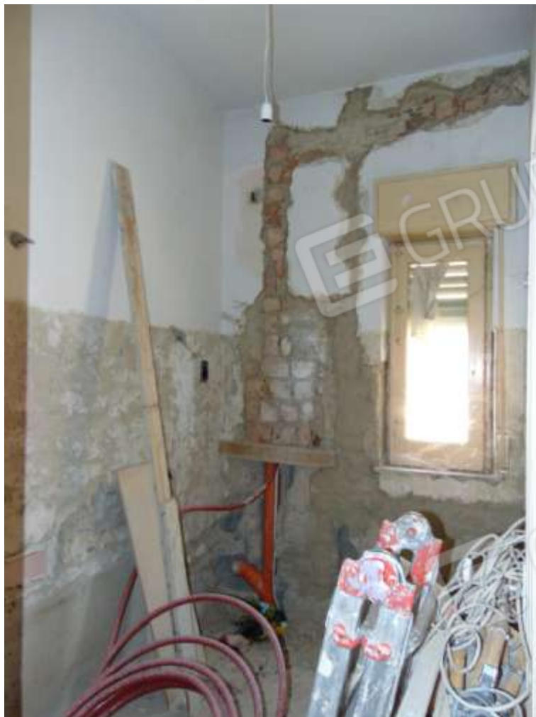
FOTO 05 - APPARTAMENTO 1° PIANO (LOTTO 2) servizio igienico
