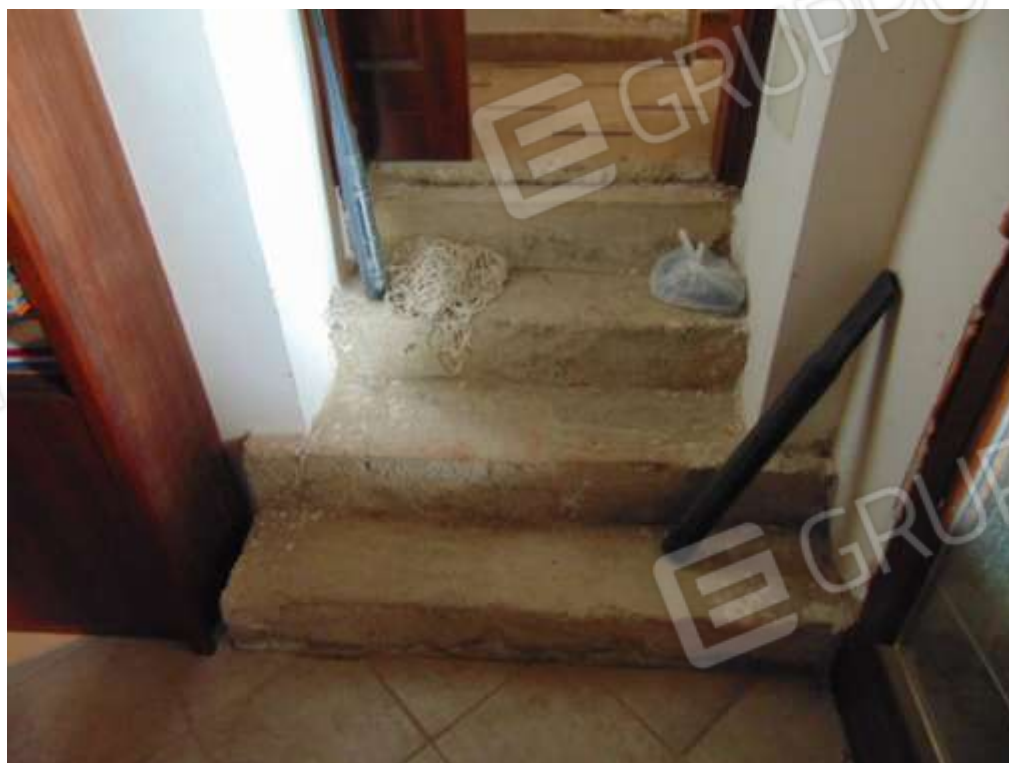
FOTO 08 - GARAGE PIANO TERRA (LOTTO 4) accesso al corridoio
