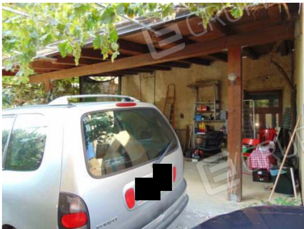
FOTO 06 - GARAGE PIANO TERRA (LOTTO 4) tettoia
