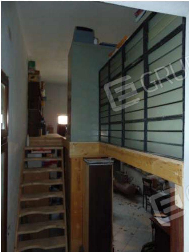
FOTO 05 - GARAGE PIANO TERRA (LOTTO 4) scala di accesso al soppalco
