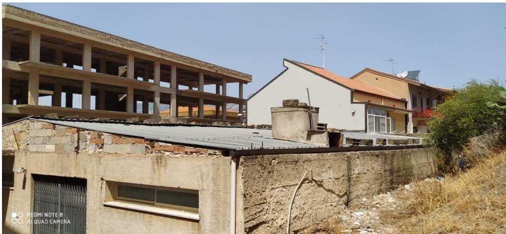
Figura 5. Vista della copertura e del prospetto contro terra
