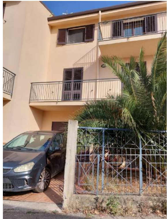
Foto 7 – Prospetto principale - corte interna
