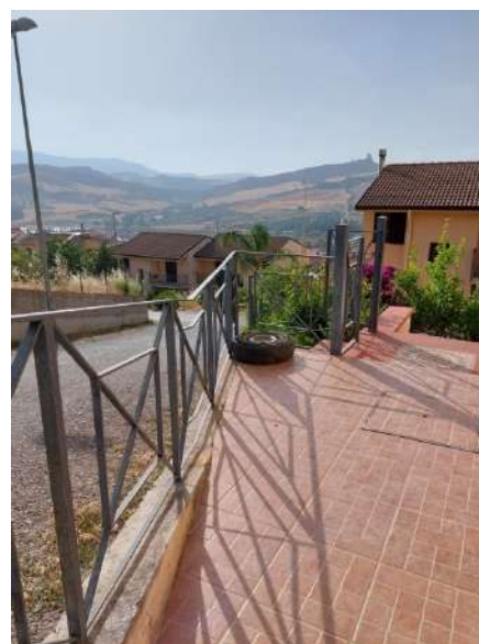
Foto 5 – Prospetto laterale - corte interna
