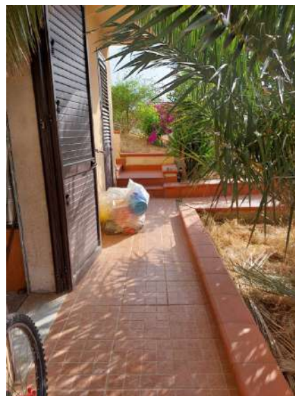
Foto 15 – Accesso alla cantina
