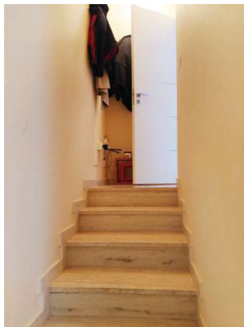
Foto 19 - Scala interna abusiva
