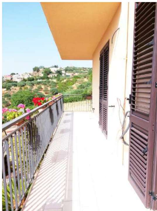
Foto 23 – Balcone piano terra
