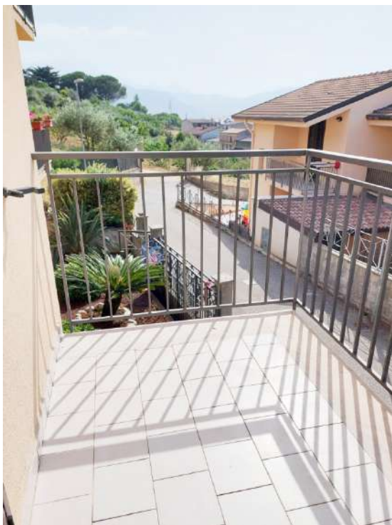
Foto 22 – Balcone piano terra
