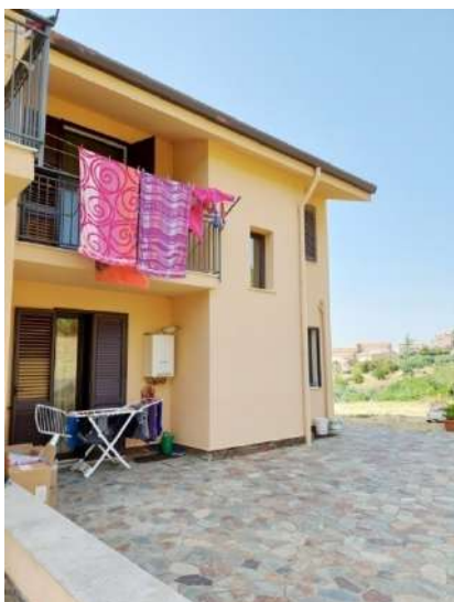
Foto 6 – Retrospetto - Corte interna
