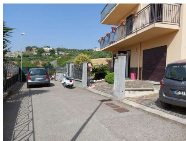
Foto 11 - Accessi al piano seminterrato
