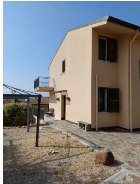
Foto 5 – Prospetto laterale - corte interna
