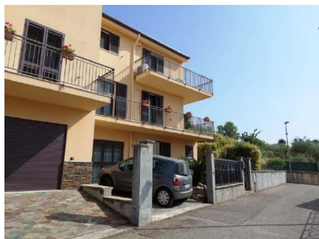
Foto 11 - Accessi al piano seminterrato
