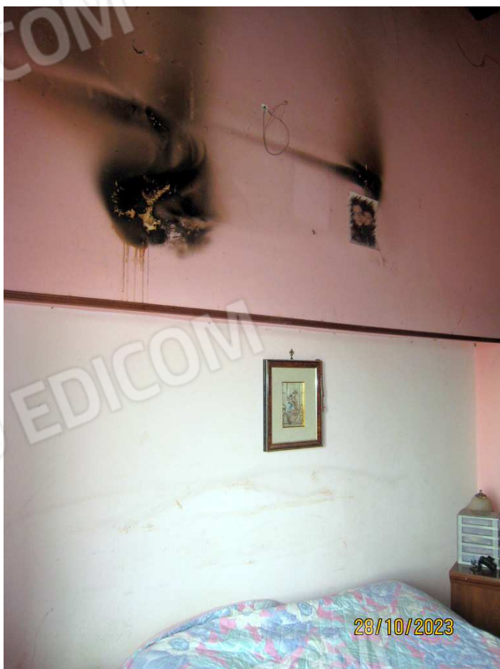
Foto n. 52-53. La camera matrimoniale con delle bruciature sulle pareti (impianto elettrico malfunzionante?).
