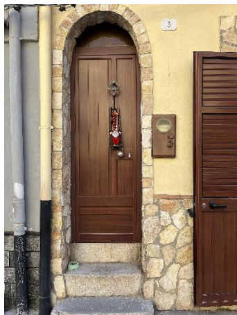
Foto 2-Accesso da largo San Calogero n.3
