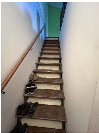
Foto 13-Scala di accesso al sottoscala
