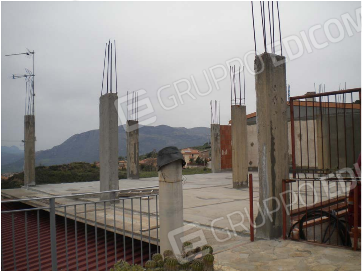
Foto n.5 – Spiccato dei pilastri al terrazzo superiore
