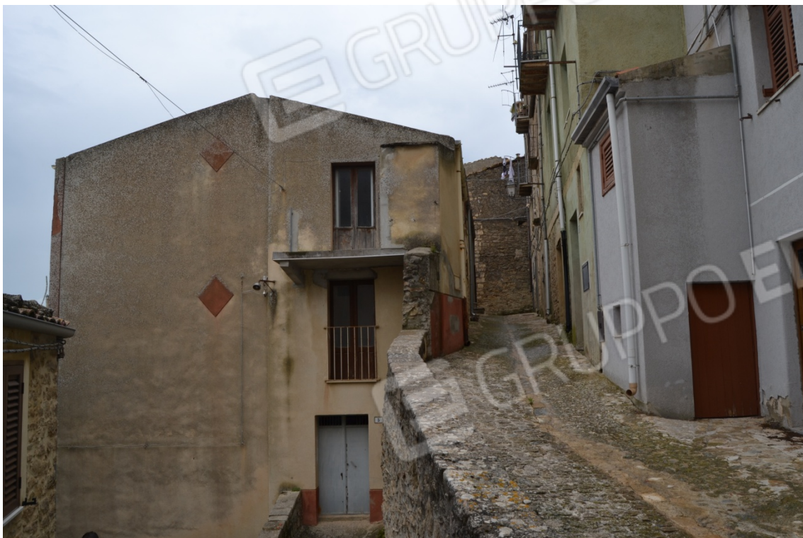
Fotografia 5 – Prospetto via Della Croce n. 5
