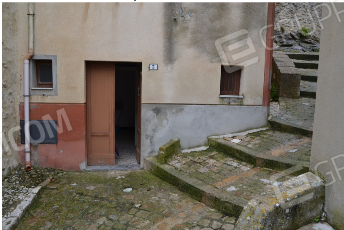
Fotografia 6 – Ingresso via Della Croce n. 3
