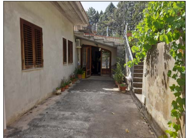
6. Ingresso piano terra e scala di accesso al piano primo
