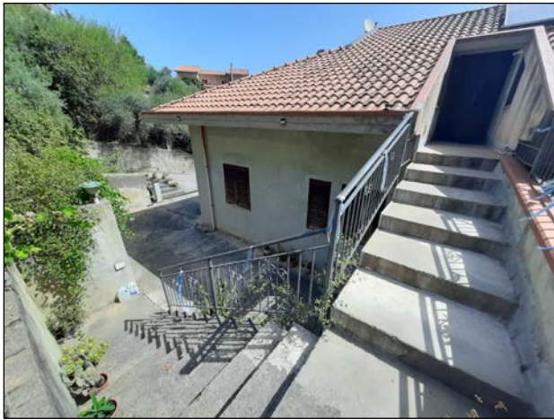
23. Scala di accesso al sottotetto
