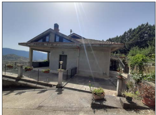
2. Prospetto nord-ovest (altra u.i.)
