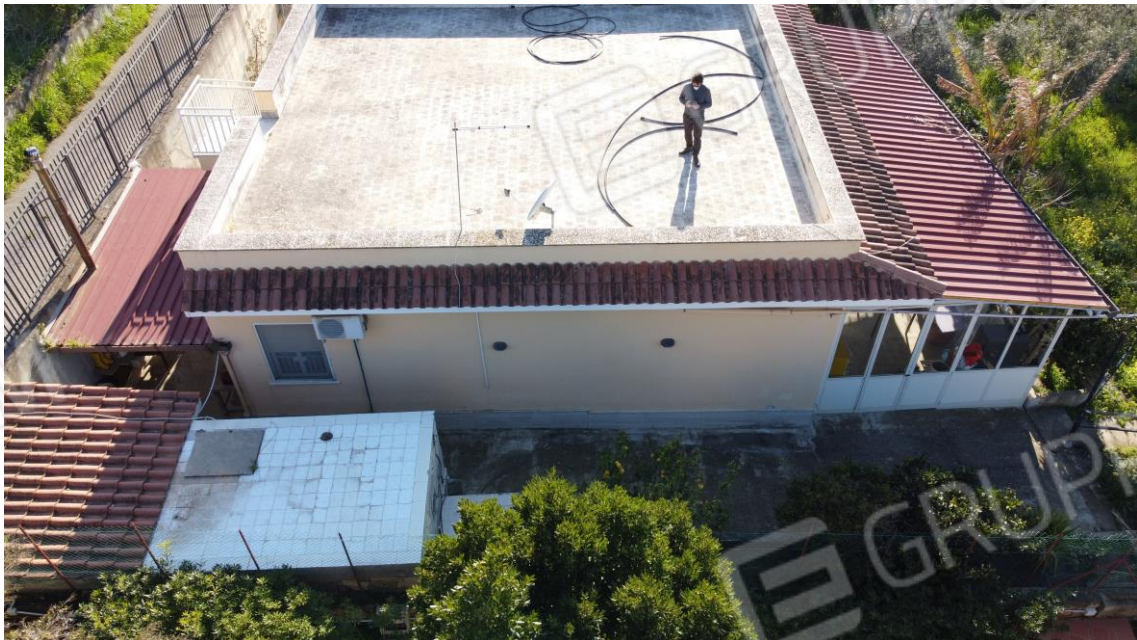
Figura 30: Vista del terrazzo di copertura
