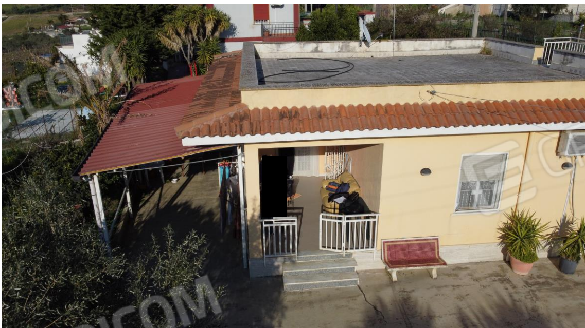
Figura 31: Vista della scala di accesso al terrazzo di copertura
