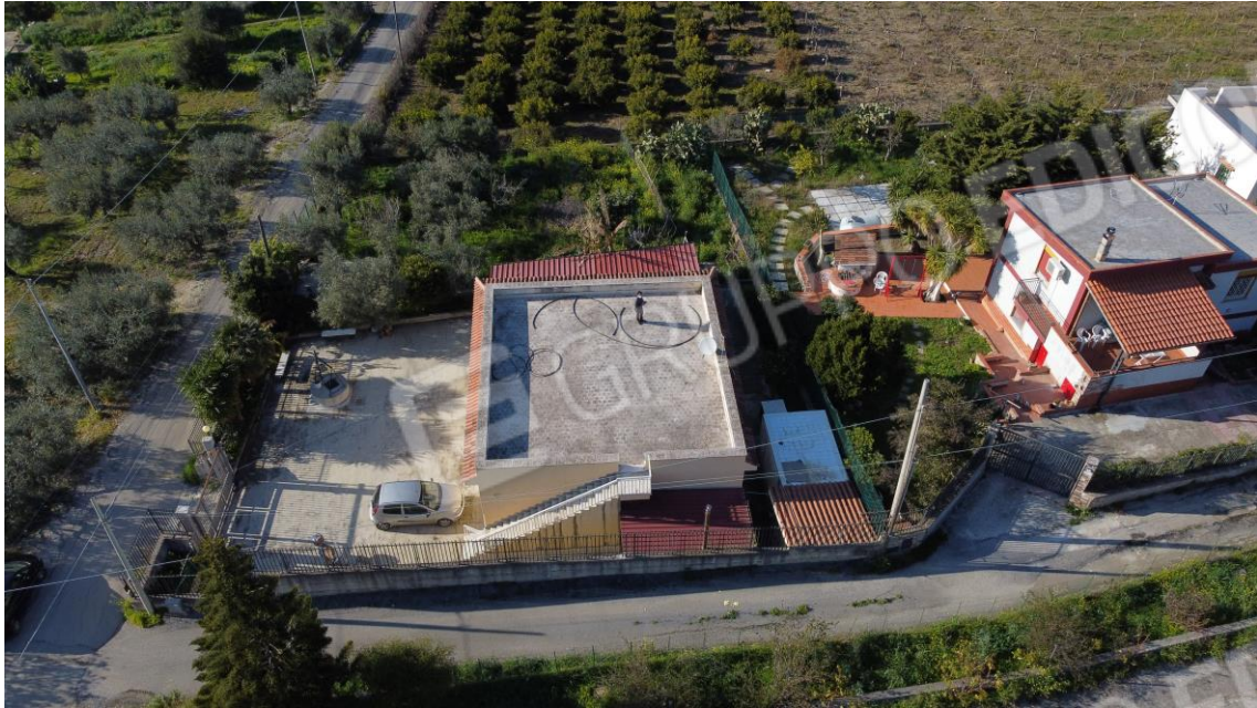
Figura 29: Vista della scala di accesso al terrazzo di copertura
