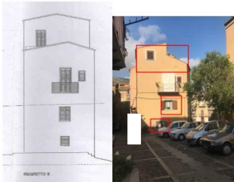
Prospetto su via Duomo , con evidenziato il volume abusivo con relativa finestra al piano terzo e la diversa posizione delle aperture di piano terra e primo.
