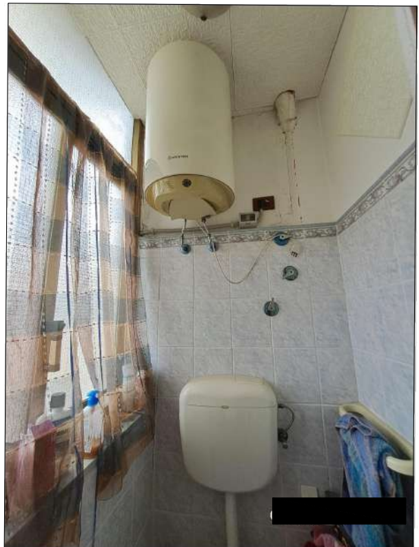
piano terzo - bagno
