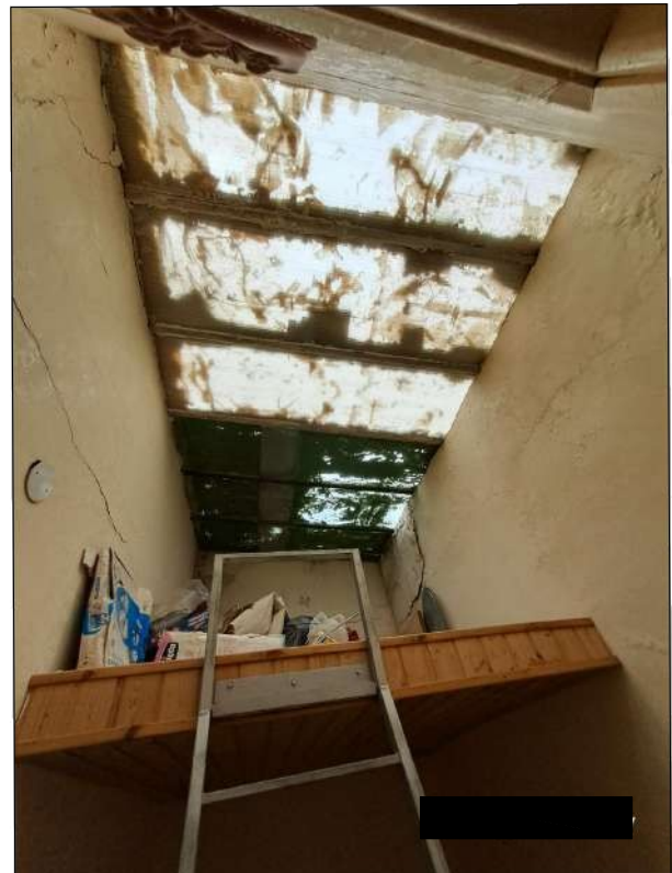
piano terzo - piccolo soppalco
