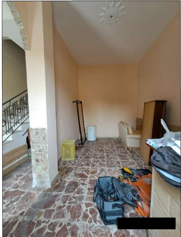
vano al piano terra
