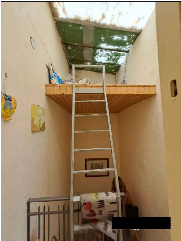
piano terzo - piccolo soppalco
