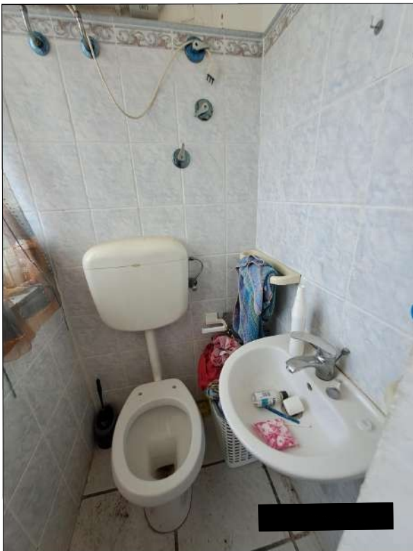
piano terzo - bagno
