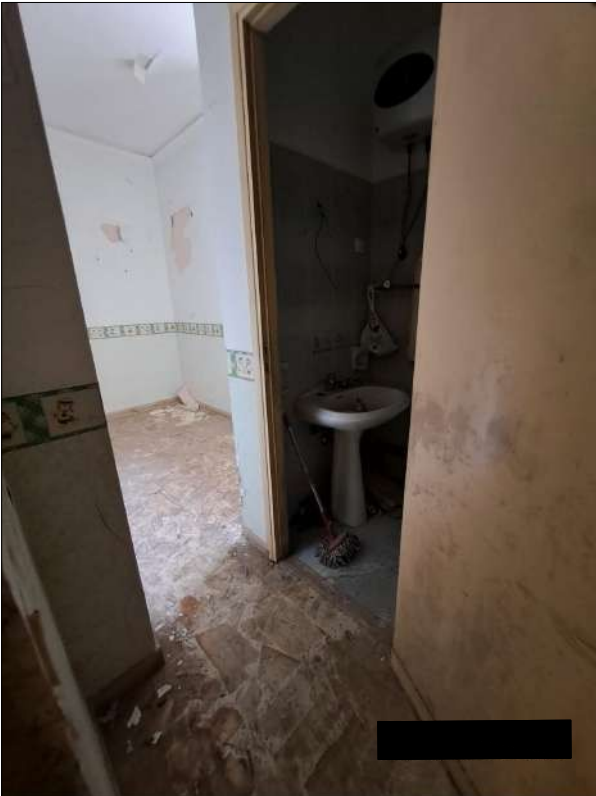
piano primo - disimpegno
