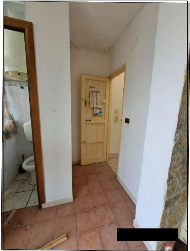
piano terzo - bagno
