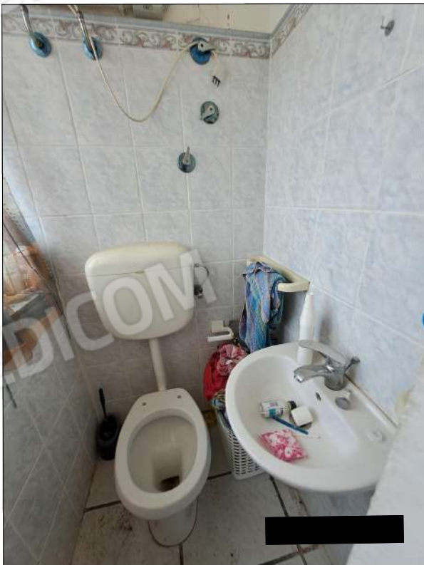
piano terzo - bagno
