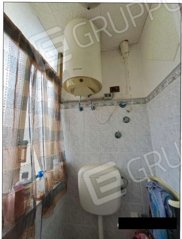
piano terzo - bagno
