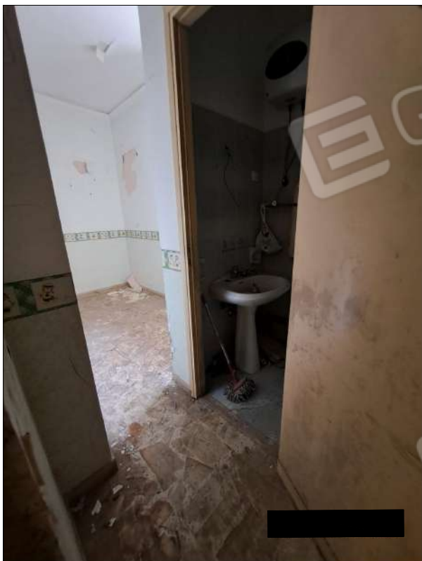
piano primo - disimpegno
