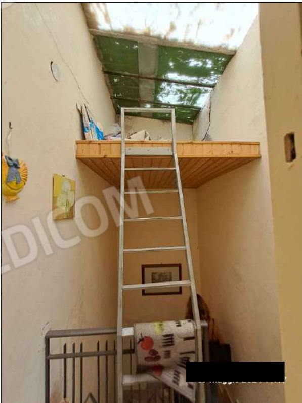
piano terzo - piccolo soppalco
