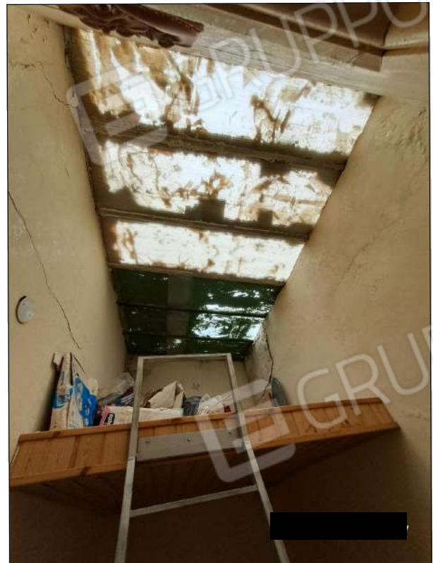
piano terzo - piccolo soppalco
