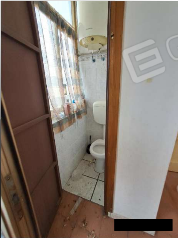
piano terzo - bagno
