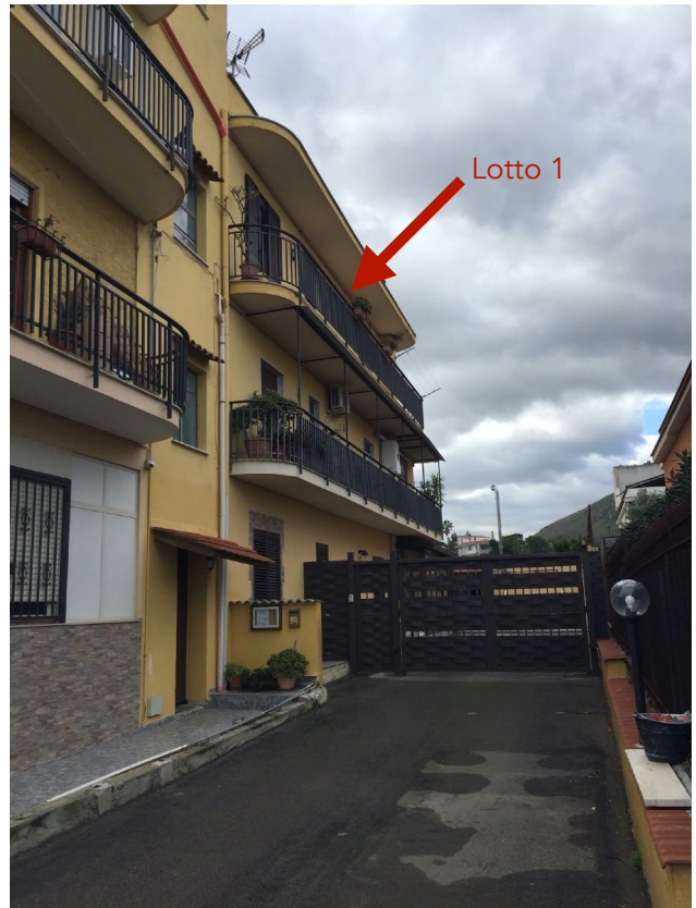
FOTO N. 2 - Vista dell'edificio dalla stradella interna
