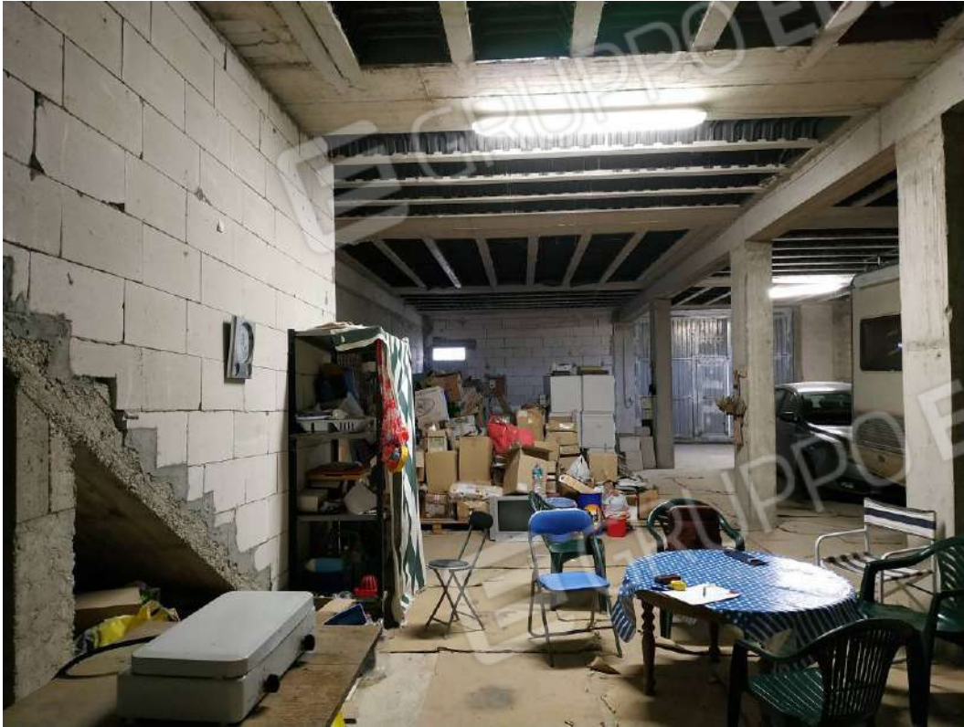
IMG 13_Magazzino, angolo Sud-Est
