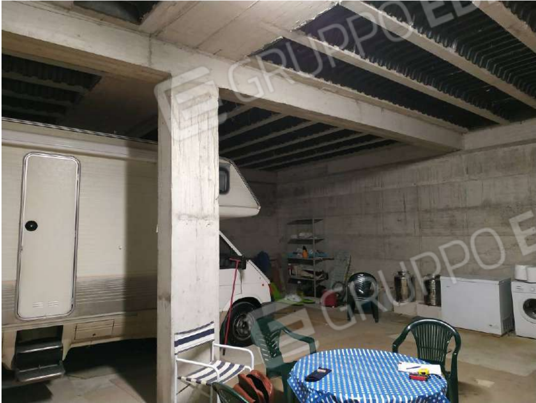
IMG 11_Lato Sud
