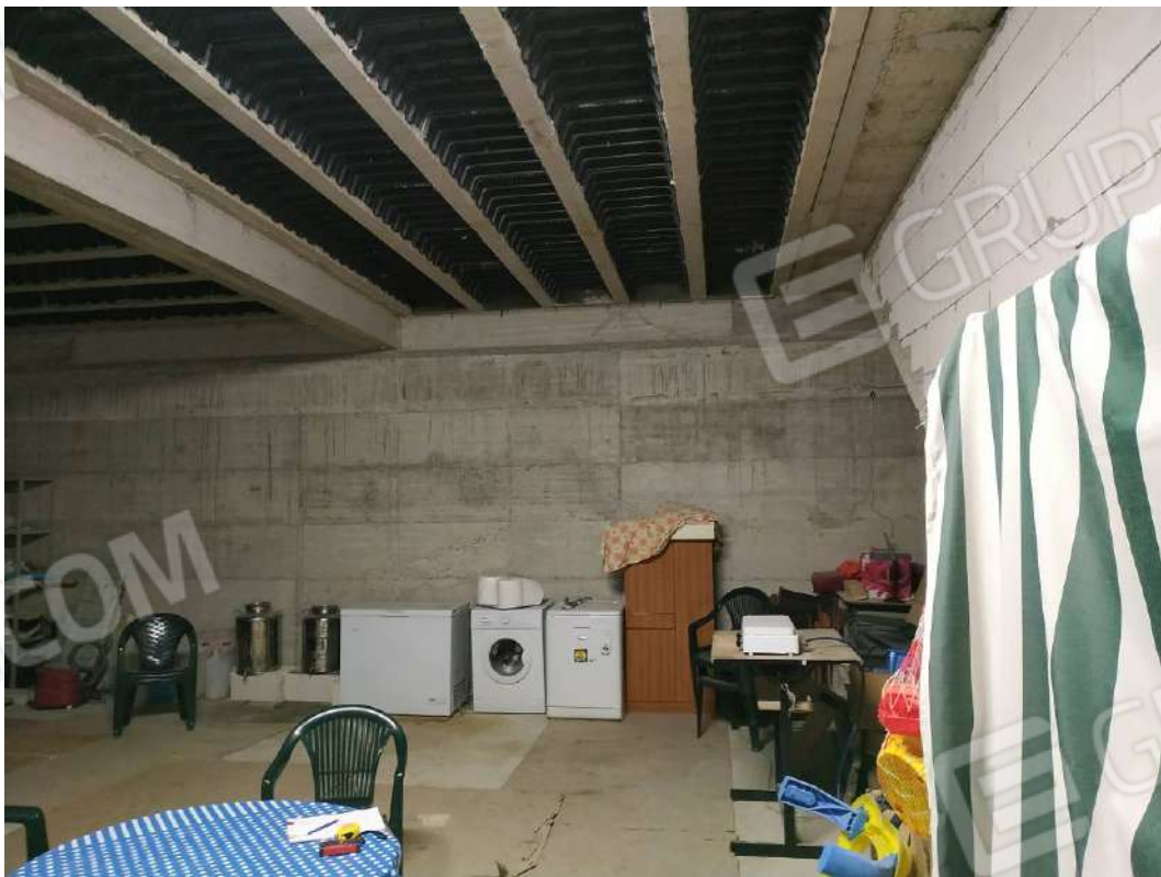
IMG 12_Lato Sud
