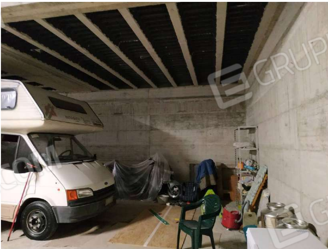
IMG 14_Magazzino, angolo Sud-Est
