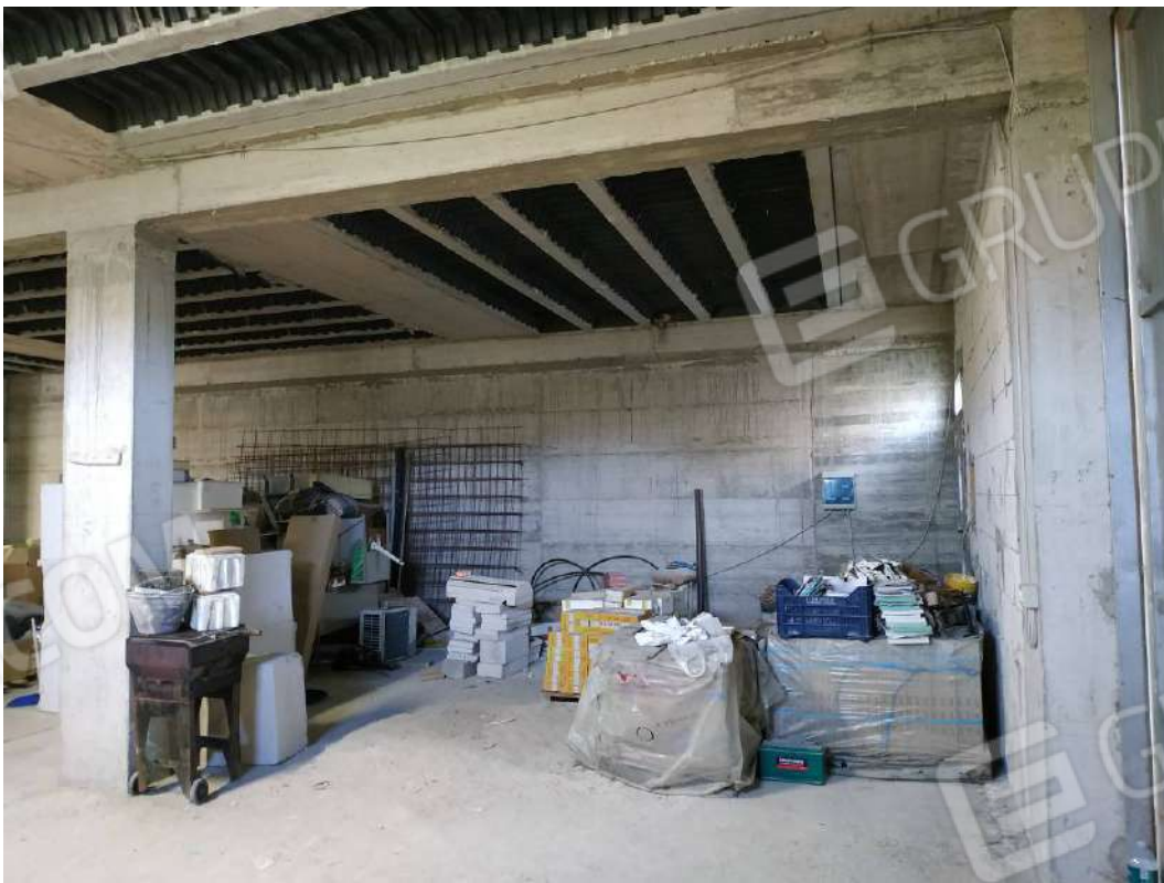
IMG 6_Magazzino, angolo Nord-Ovest
