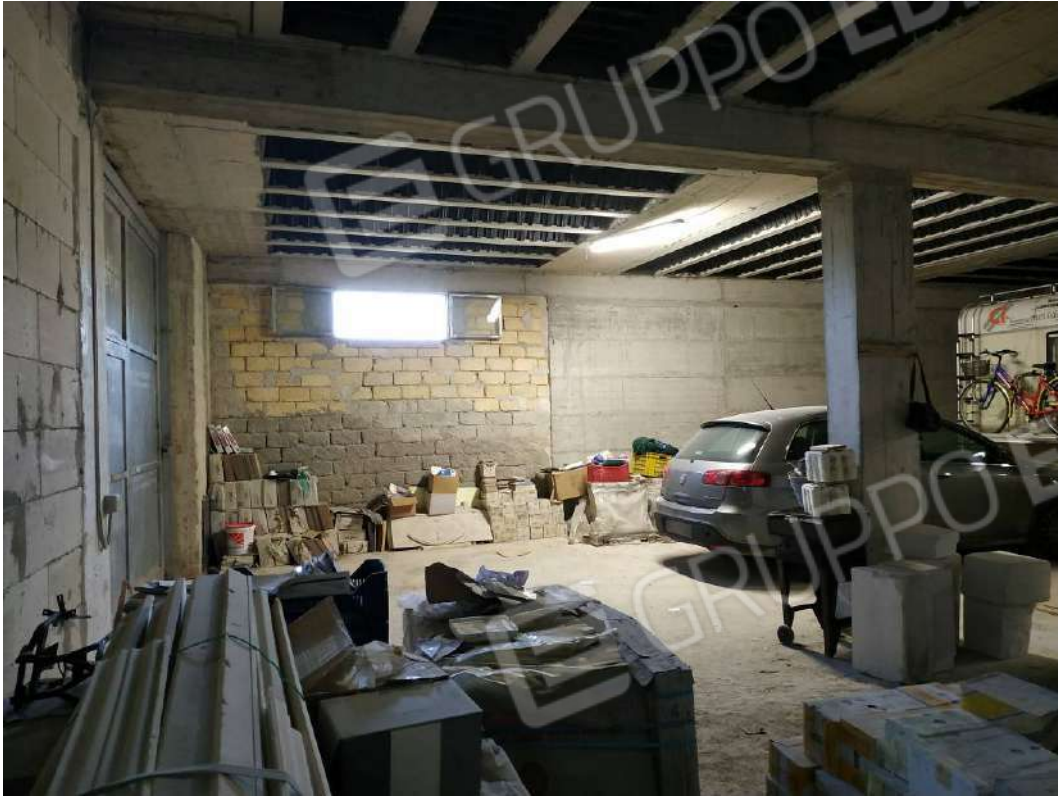
IMG 7_Magazzino, angolo Sud-Ovest
