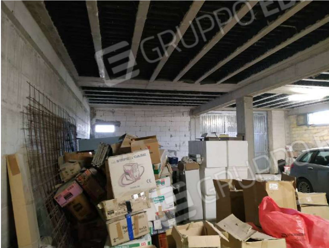
IMG 9_Lato Sud
