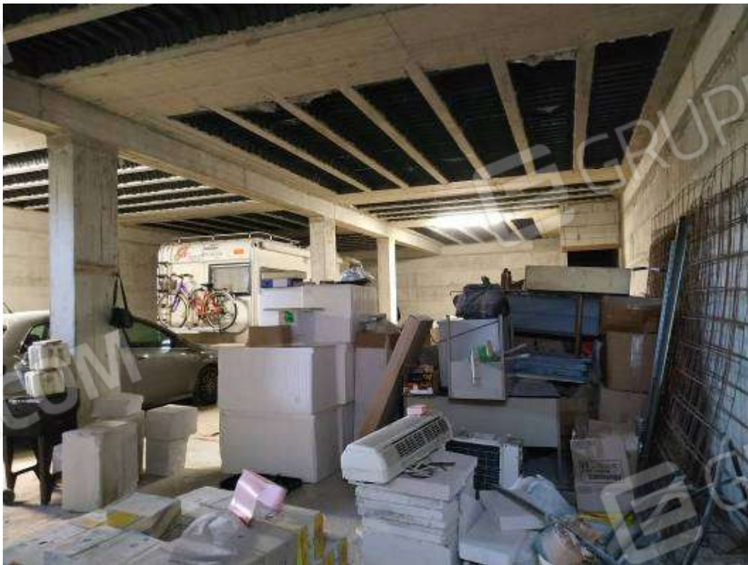
IMG 8_Magazzino, angolo Sud-Ovest
