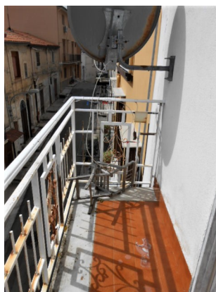
18. Piano 2°, il balcone su via Filpi
