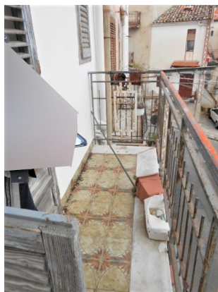
15. Piano 1°, il balcone su via Filpi
