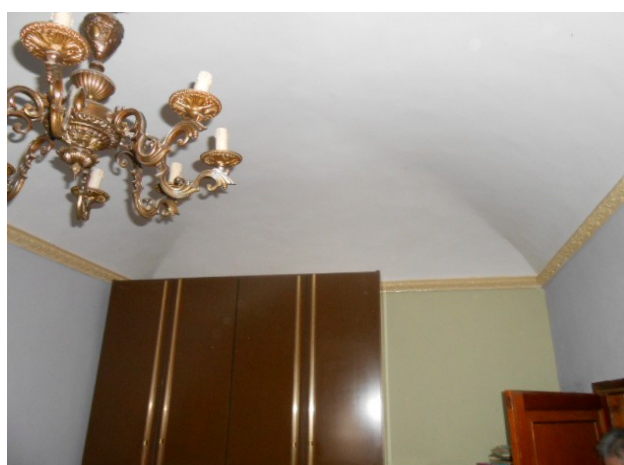
14. Primo piano, il soffitto a volta
