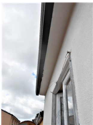
22. Piano 2°, la grondaia del tetto a falda, vista dal balcone
