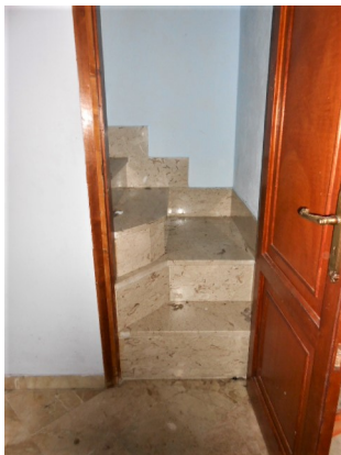
17. Primo 1°, l'inizio della scala che conduce al piano 2°
