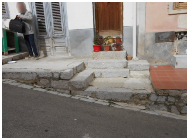
3. Particolare marciapiede su via Filpi nn. 7-9
