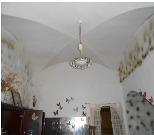
7. Interno piano terra con soffitto a volta a crociera
