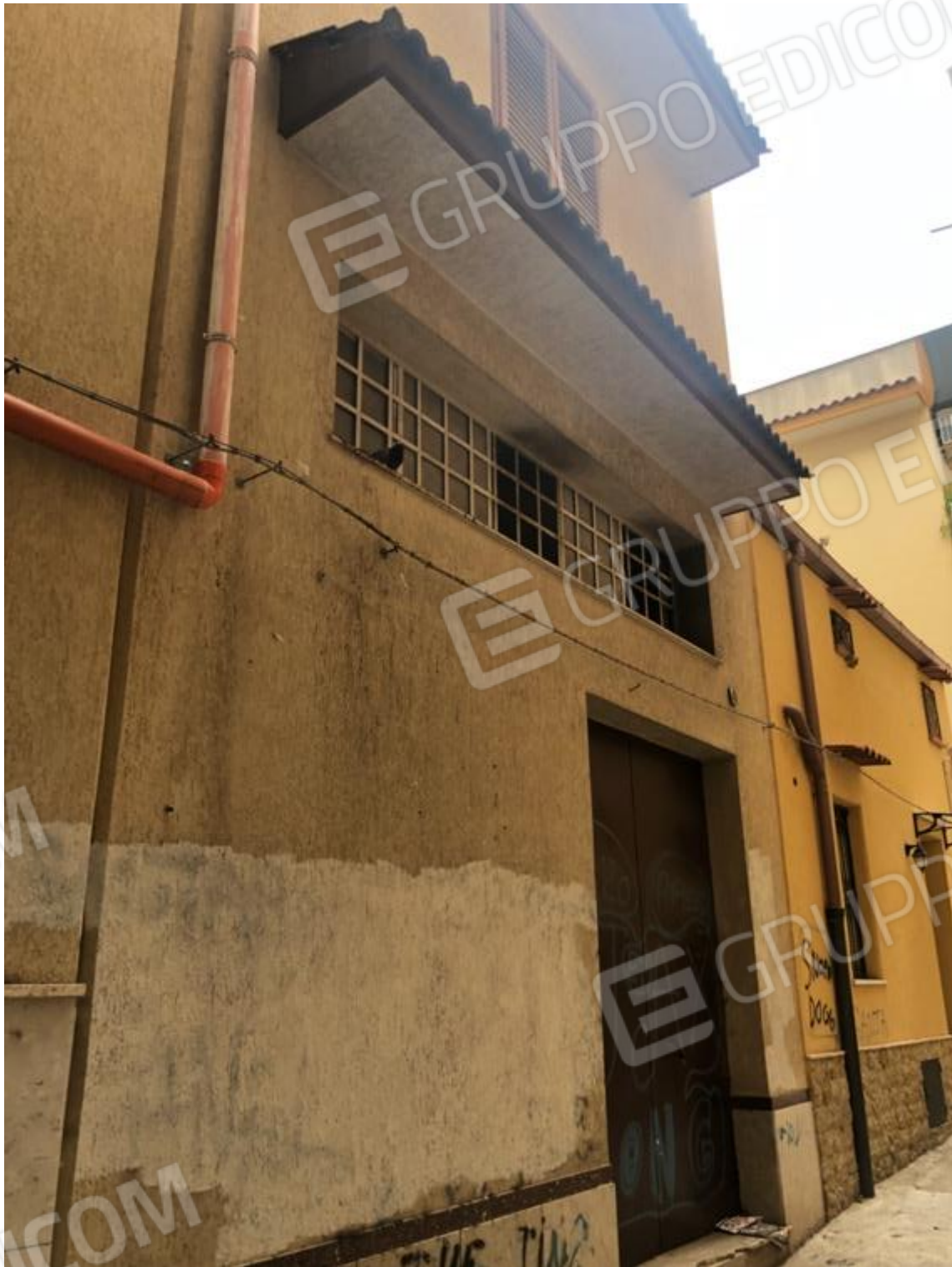
Foto 14 – Vista dell'ingresso del lotto 3 da via La Barbaera.
