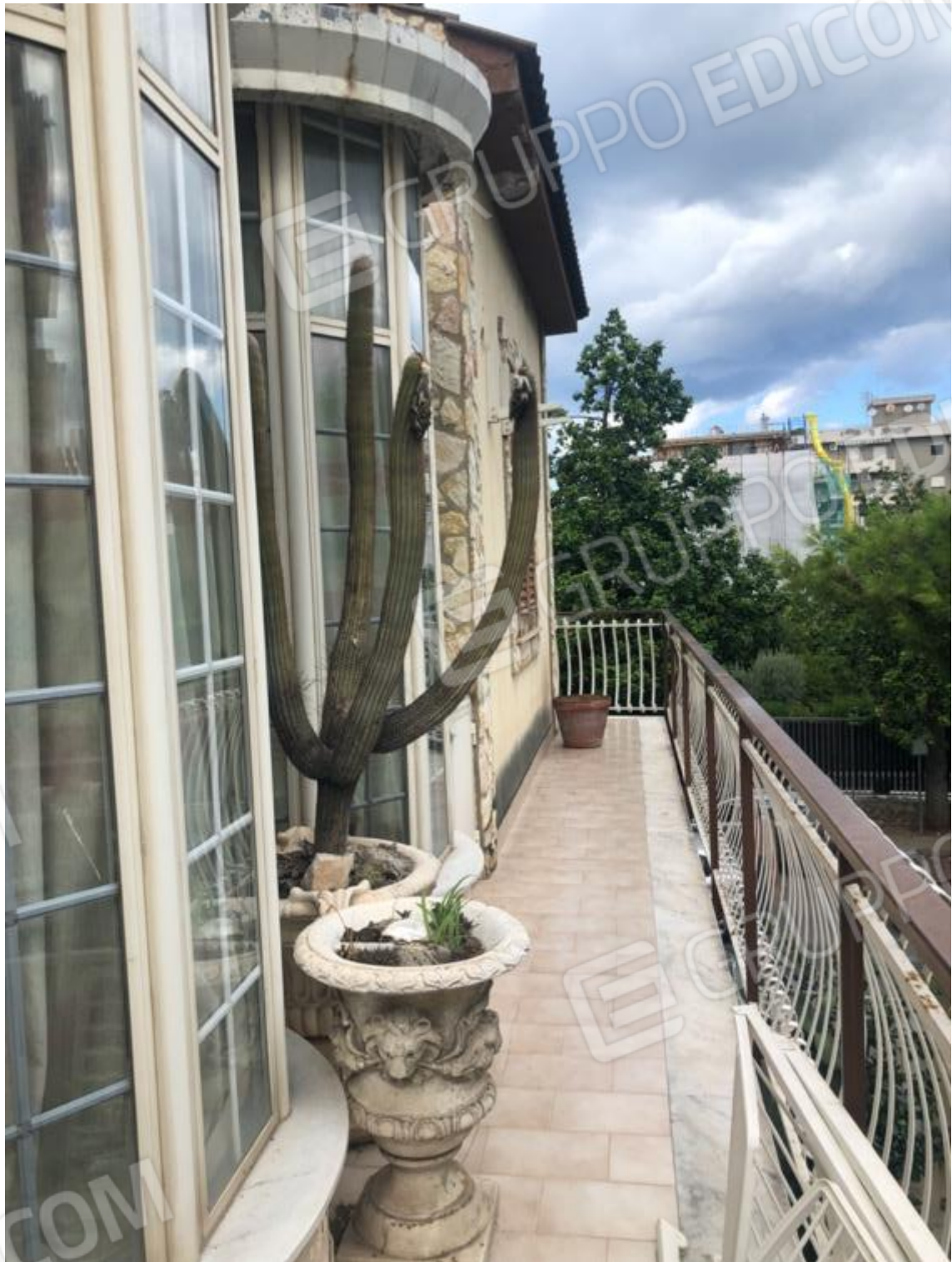
Foto 34 – Balcone che affaccia sul cortile interno. Sulla sinistra le vetrate in alluminio della veranda
