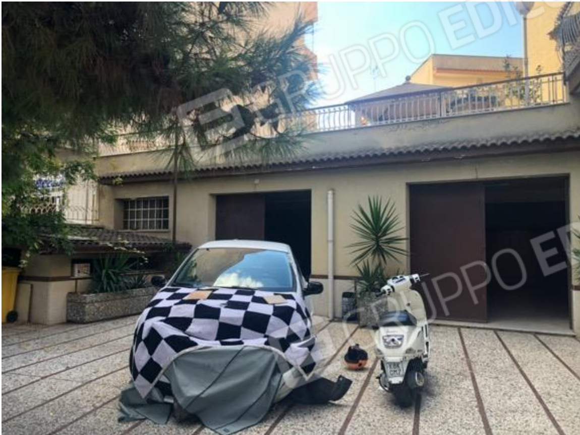
Foto 3 – Portoni di ingresso ai magazzini di cui al lotto 1. Sulla sinistra il locale caldaia.
