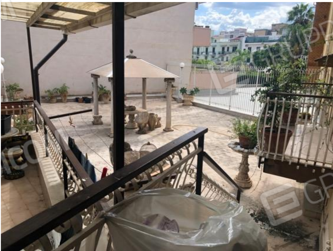
Foto 18 – Vista della terrazza dall'uscita di cui alla foto 17
