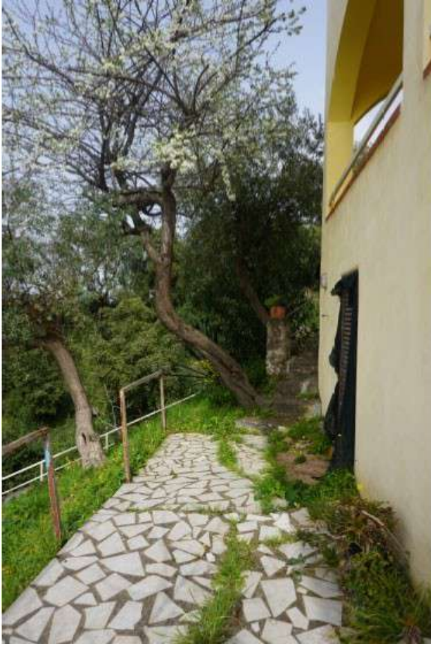
Esterno piano seminterrato
