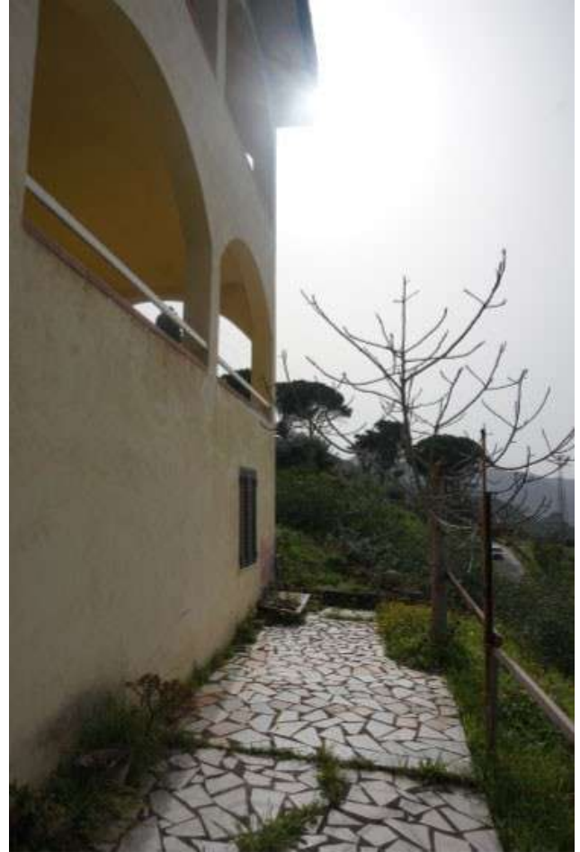
Esterno piano seminterrato
