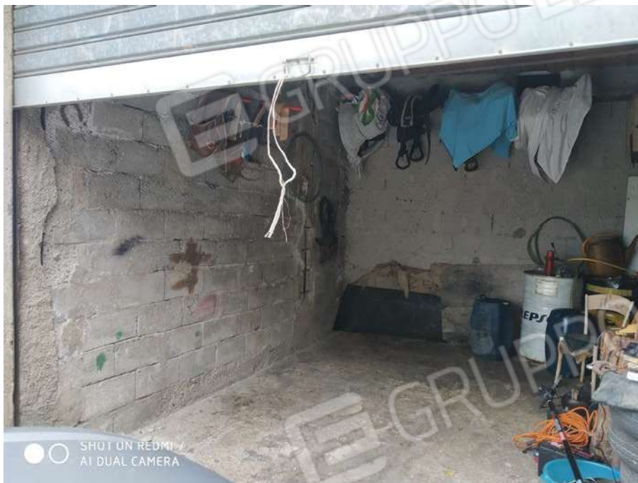
FIGURA 18 – FOTO INTERNO – GARAGE – BENE 3
