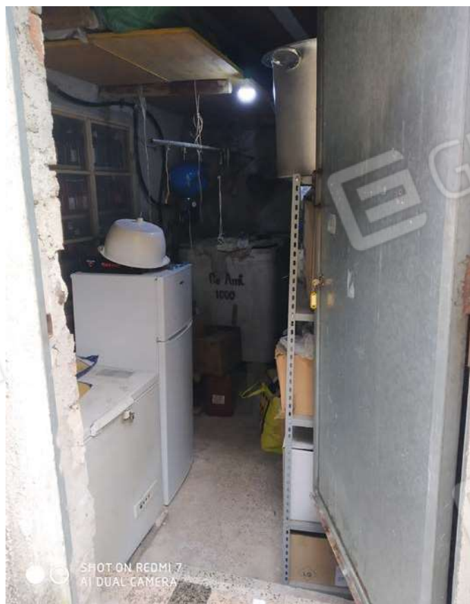
FIGURA 12 - FOTO ESTERNO - INGRESSO MAGAZZINO- BENE 2
