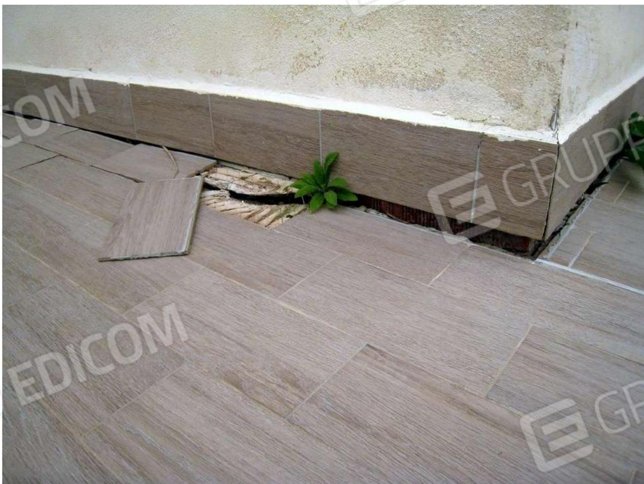
Foto n. 29. La zona in cui il pavimento si è abbassato di più. Circa 4-5 centimetri all'angolo.
