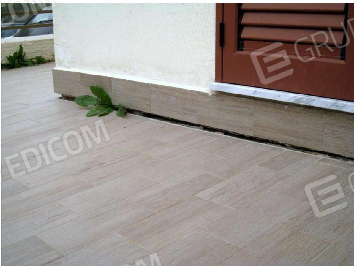
Foto n. 27. Abbassamenti del pavimento rispetto lo zoccolo di diversi centimetri.
