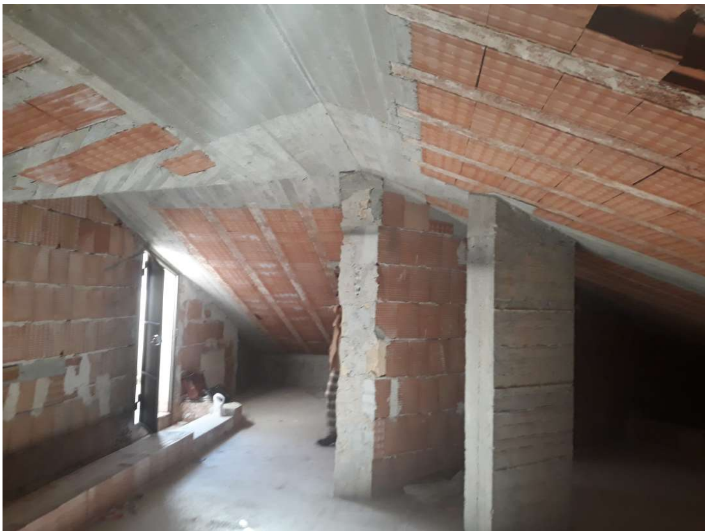
2. INTERNO DEL SOTTOTETTO
