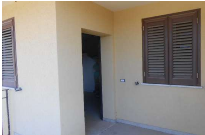
8. PORTICO CON L'ACCESSO AL PIANO TERRA
