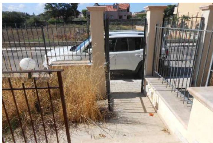
2. LA CORTE SUD PIANO TERRA, LATO VIA SANTA MARINA QUARTO
