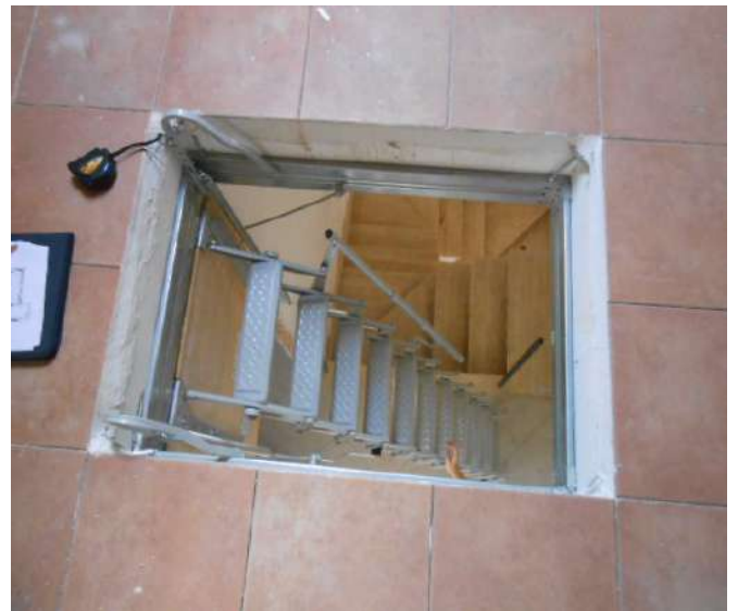
15. SOTTOTETTO. IL PAVIMENTO E LA BOTOLA CON A SCALETTA RETRATTILE
