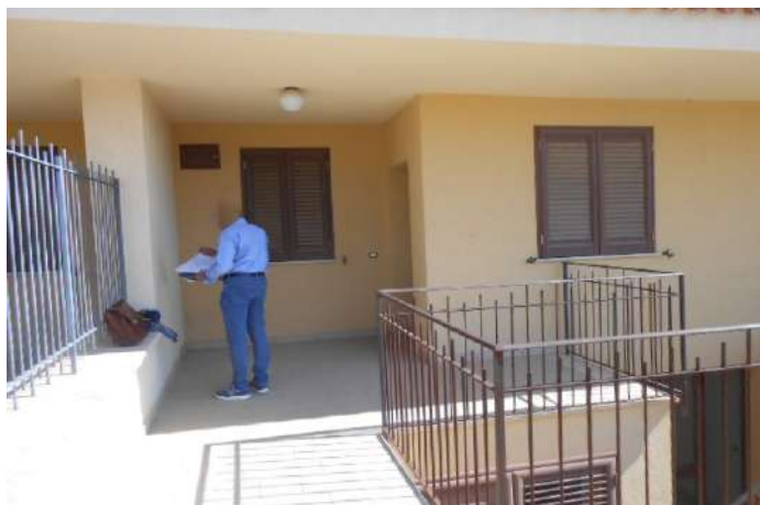
5. PIANO TERRA. IL PORTICO DI ACCESSO SUD LATO VIA SANTA MARINA QUARTO
