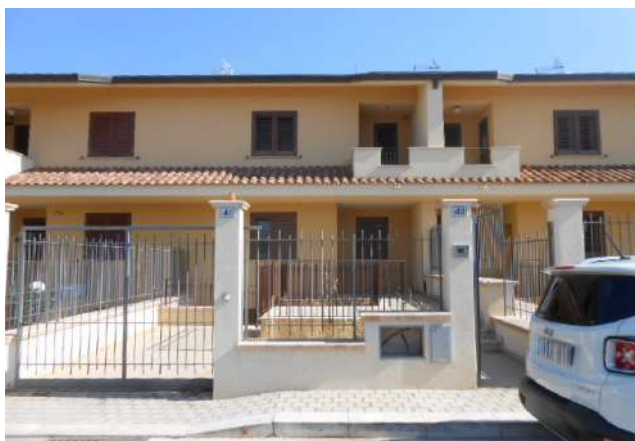
2. PROSPETTO SU VIA SANTA MARINA QUARTO, CIV, 41-43
