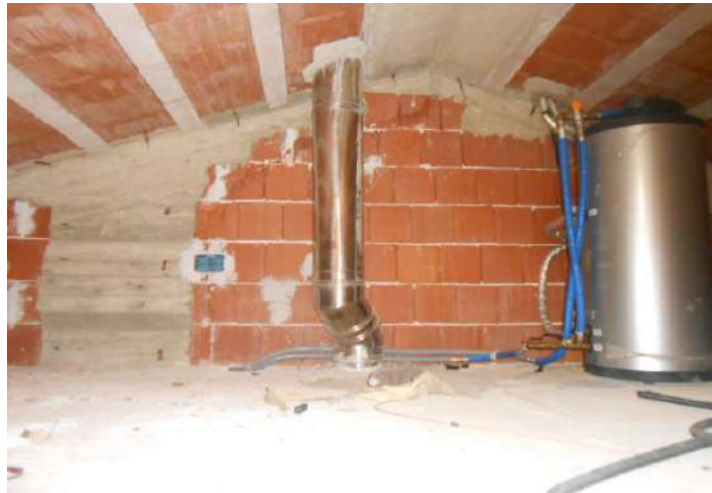
17. IL SOTTOTETTO VISTO DALL'INTRADOSSO DI COLMO
