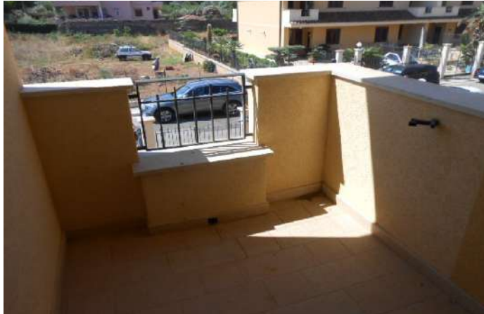
13. PIANO 1. LA LOGGETTA SUD LATO VIA SANTA MARINA QUARTO
