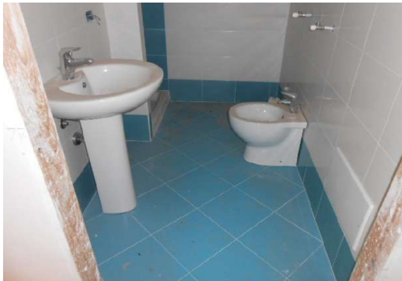
20. PIANO SOTTOSTRADA (S1). IL WC DOCCIA
