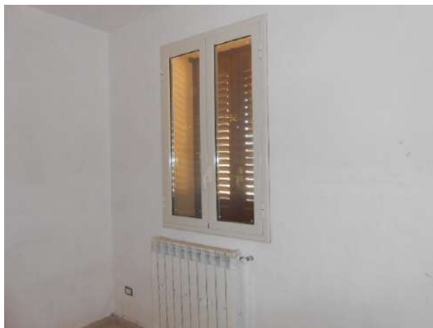
10. CAMERA CON PARTICOLARE DEI RADIATORI
