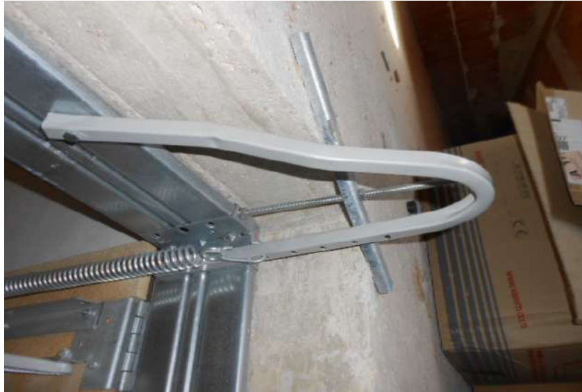
14. PARTICOLARE DEL CORRIMANO DI ARRIVO NEL SOTTOTETTO
