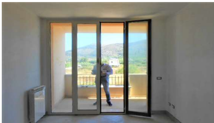
14. PORTAFINESTRA AL PIANO 1 SU BALCONE NORD LATO VIA SANTA MARINA TERZO
