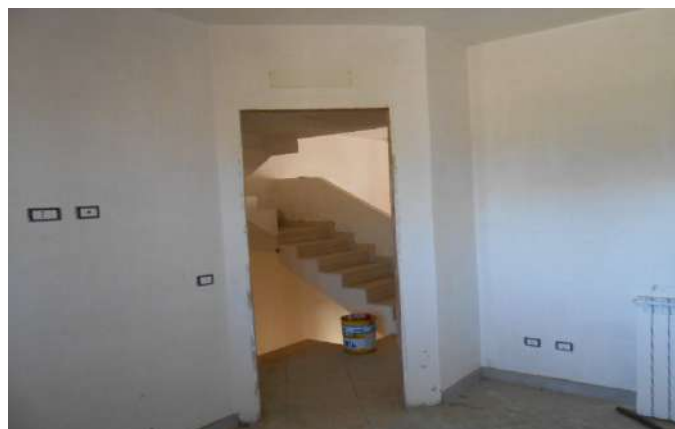
13. PIANO TERRA, CUCINA. MANCA LA PORTA. SI NOTA IN FONDO LA MANCANZA DELLA RINGHIERA NELLA SCALA INTERNA
