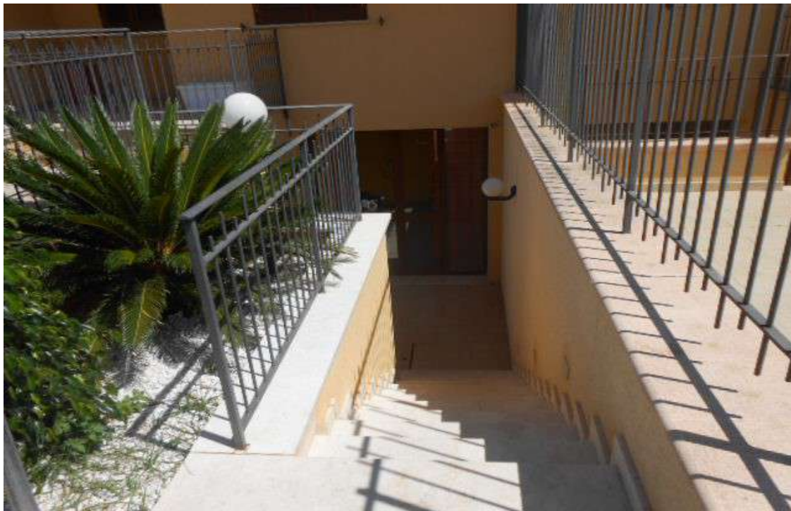
10. PIANO TERRA, CORTE SUD. SCALA ESTERNA PER ACCESSO AL PIANO SOTTOSTRADA (S1)
