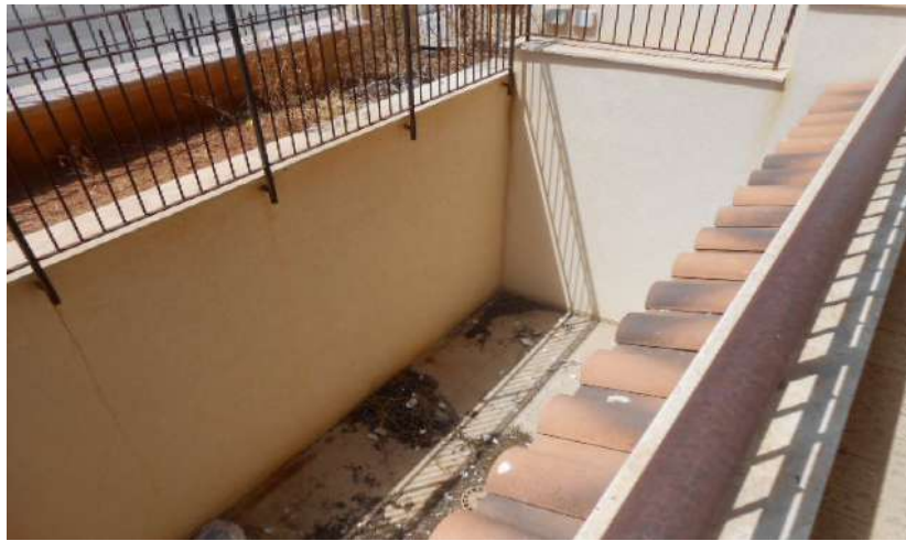
5. VISTA DALL'ALTO DELLA CORTE SUD AL PIANO SOTTOSTRADA (S1), LATO VIA SANTA MARINA QUARTO
