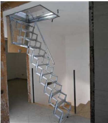
14. PIANO 1. LA SCALETTA RETRATTILE PER L'ACCESSO AL SOTTOTETTO
