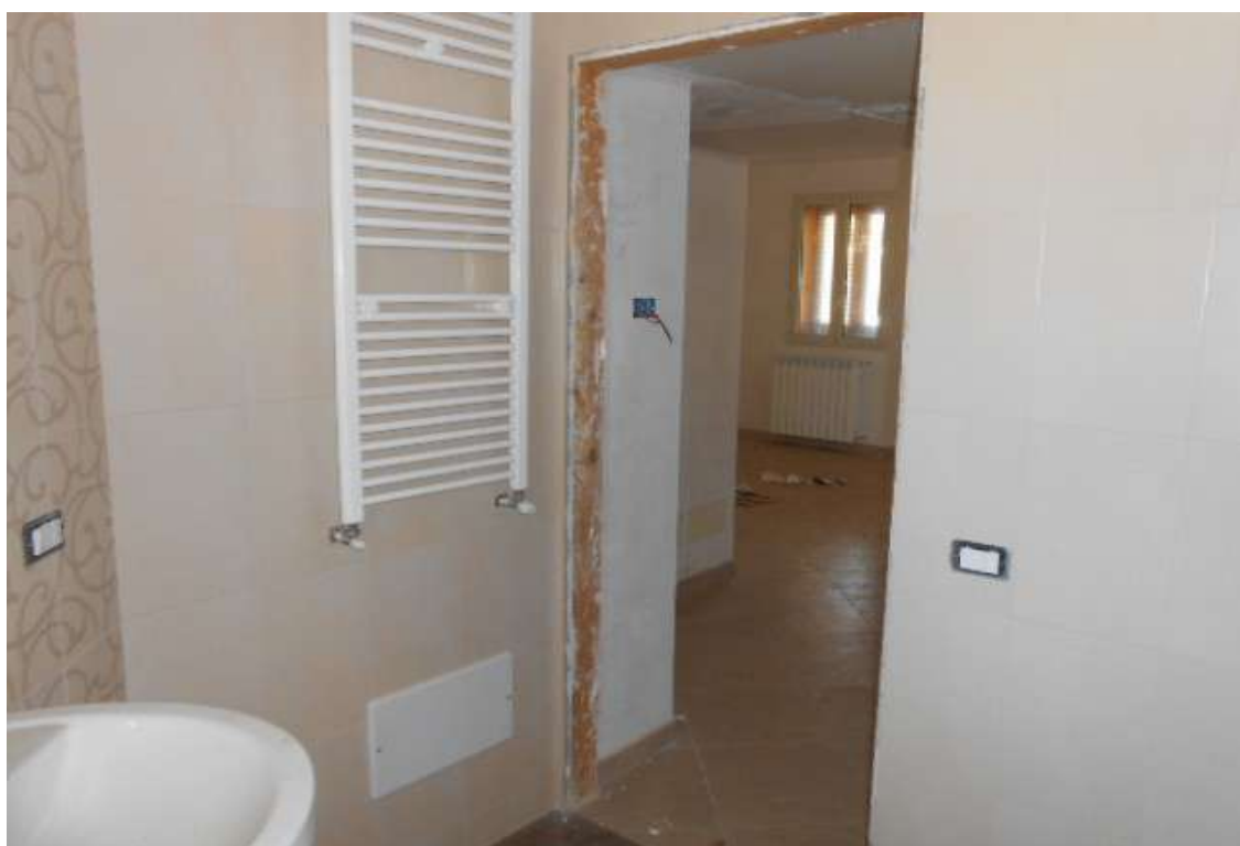
11. PIANO TERRA. IL BAGNO, COME TUTTI I VANI INTERNI, È PRIVO DI PORTA INTERNA
