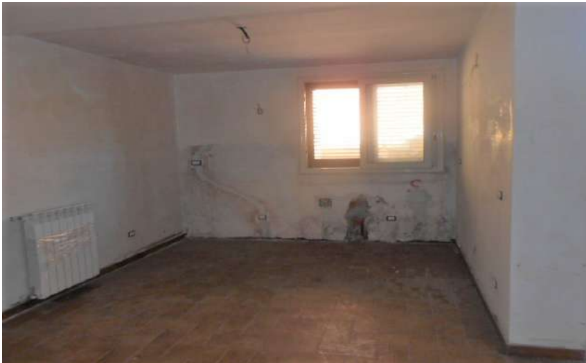
18. PIANO SOTTOSTRADA. INTERNO
