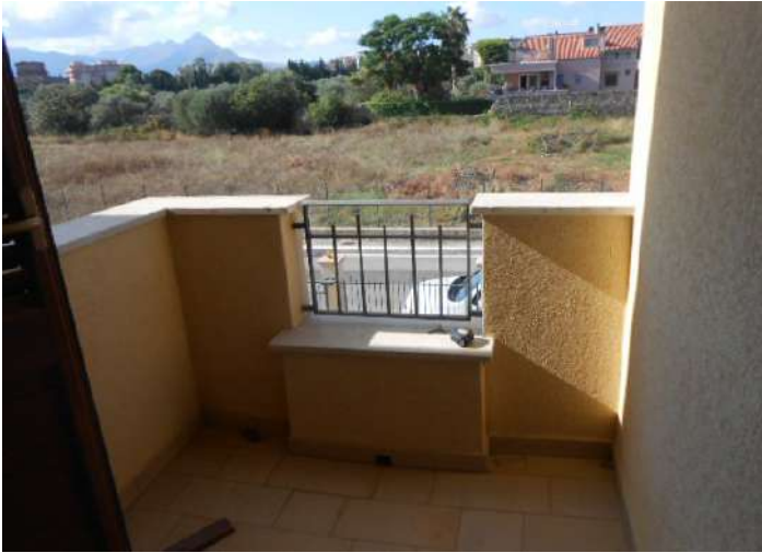
12. PIANO 1. LA LOGGETTA SUD LATO VIA SANTA MARINA QUARTO
