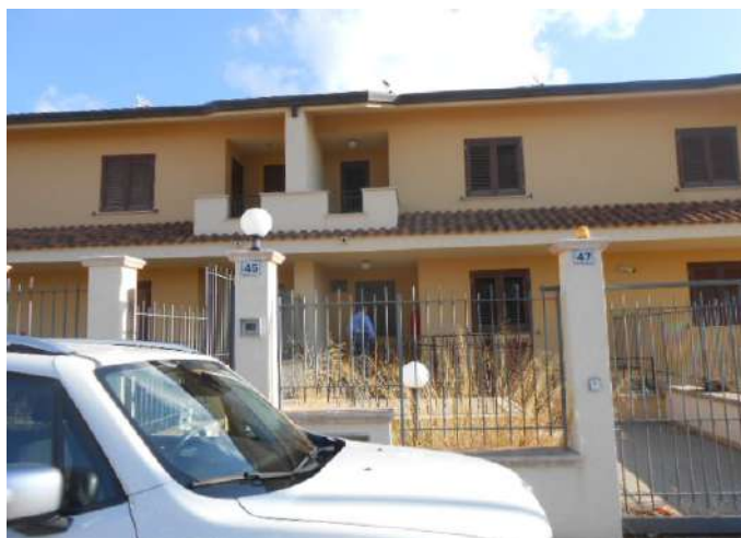
1. PROSPETTO SU VIA SANTA MARINA QUARTO CIV. 45-47
