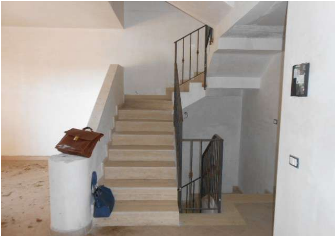
9. PIANO TERRA. LA SCALA INTERNA
