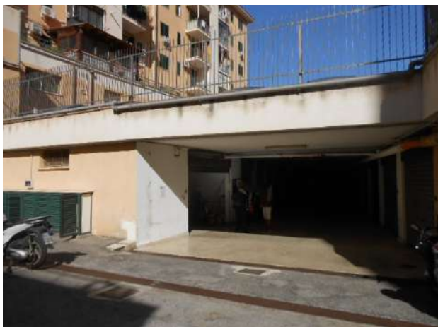
3. L'INGRESSO DELLA CORSIA DI SCORRIMENTO COPERTA CONDOMINIALE VISTA DALLA CORTE CONDOMINIALE. IL BOX E' IL PRIMO A SINISTRA ENTRANDO NELLA CORSIA DI SCORRIMENTO. LA FINESTRA CHE SI NOTA A SINISTRA DELLA FOTO APPARTIENE AL BOX.
