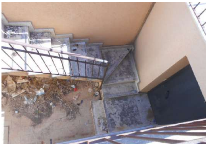
19. CORTE NORD AL PIANO SOTTOSTRADA. SI NOTA LA PORTA (INACCESSIBILE PERCHÉ BLOCCATA) DEL LOCALE AUTOCLAVE E CISTERNA
