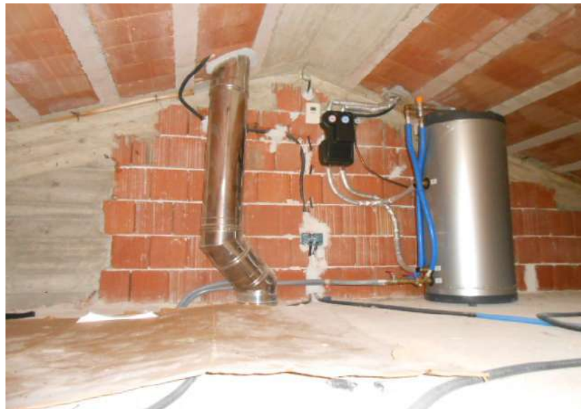
15. INTERNO DEL SOTTOTETTO
