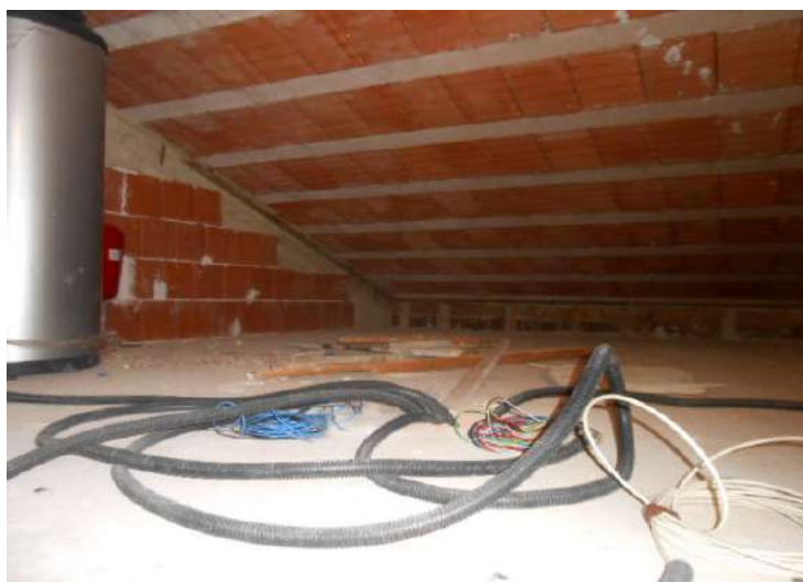
18. IL SOTTOTETTO VISTO DALL'INTRADOSSO DI GRONDA
