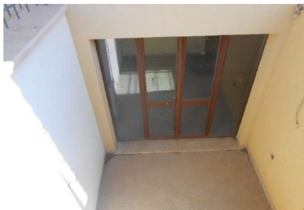
7. CORTE SUD DEL PIANO S1 CUI SI ACCEDE DALLA PORTAFINESTRA VISIBILE NELLA FOTO
