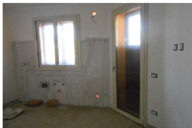
9. VANO CUCINA CON PREDISPOSIZIONE IDRAULICA SOTTO FINESTRA. DALLA PORTAFINESTRA SI ACCEDE ALLA CORTE NORD
