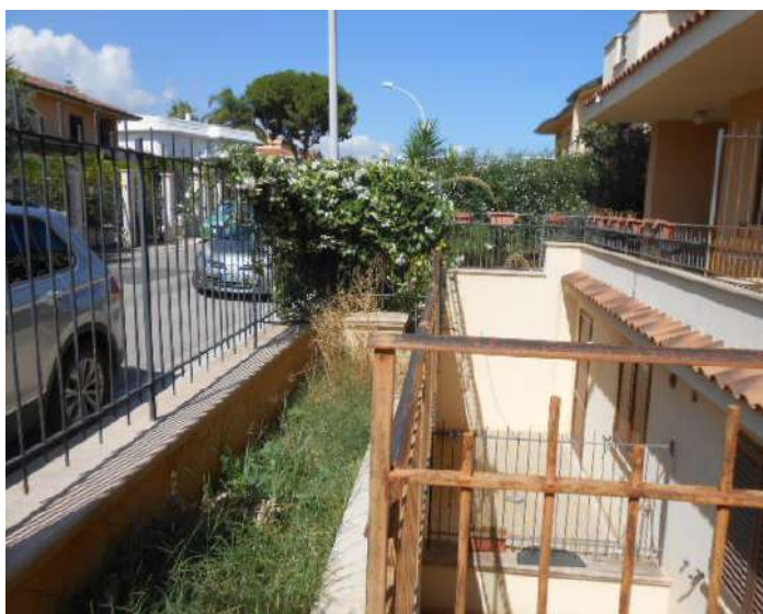
4. L'AIUOLA DELLA CORTE SUD (LATO VIA SANTA MARINA QUARTO)
