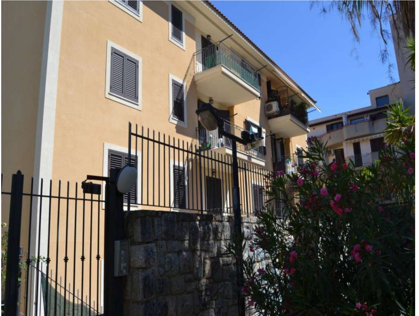
2. VISTA DAL RETRO PROSPETTO DEL CONDOMINIO CICERONE DA DOVE SI ACCEDE AI POSTO AVUTO COPERTI ATTRAVERSO IL CANCELLO VISIBILE IN PARTE A SINISTRA DELLA FOTO.
