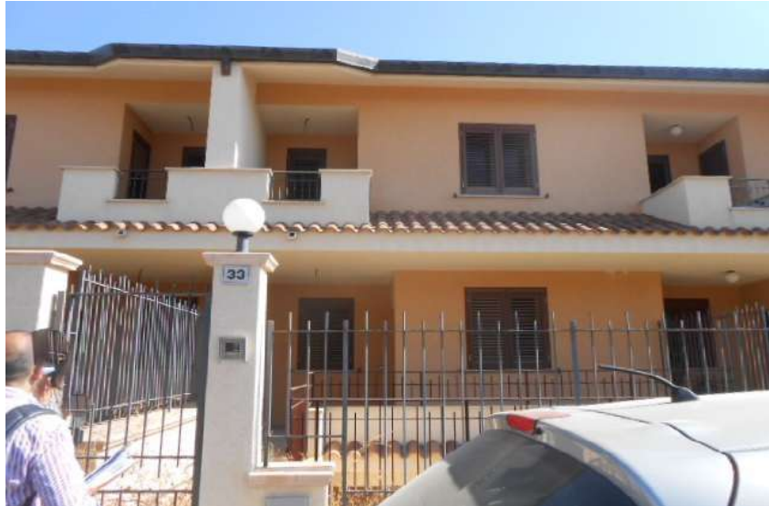
1. PROSPETTO SU VIA SANTA MARINA QUARTO, CIV 33
