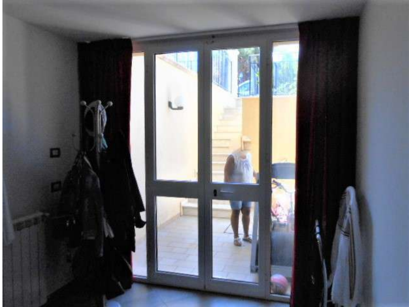
11. PIANO SOTTOSTRADA (S1). PORTAFINESTRA DI ACCESSO ALLA E DALLA CORTE SUD (LATO VIA SANTA MARINA QUARTO)
