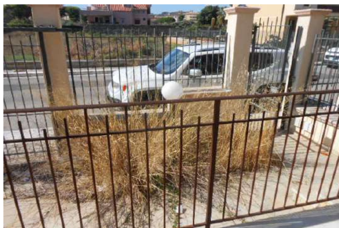
3. LA CORTE SUD PIANO TERRA, LATO VIA SANTA MARINA QUARTO
