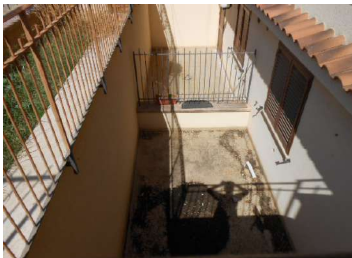
5. LA CORTE SUD DEL PIANO SOTTOSTRADA S1
