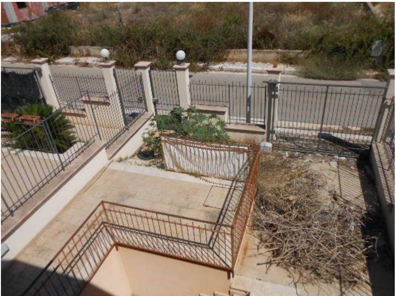
21. LA CORTE NORD, LUNGO LA VIA SANTA MARINA TERZO, VISTA DAL PIANO 1
