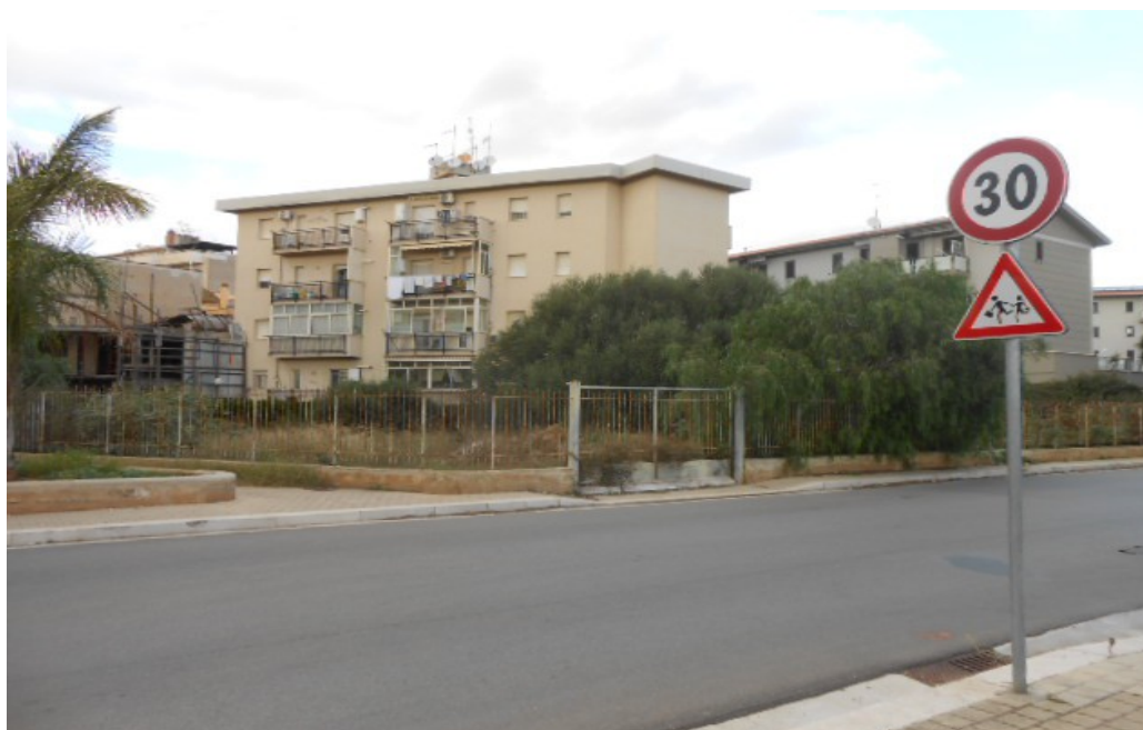
5. Via Santa Marina, Bagheria. Il lotto 2 (che corrisponde al Lotto G del PdL n. 46 di Bagheria) è recintato e provvisto di cancello carrabile.
