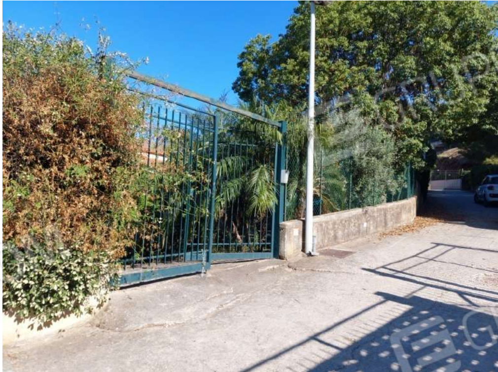
Foto 5– accesso all'unità immobiliare
