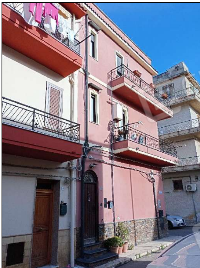
Foto 3 – Vista edificio residenziale
