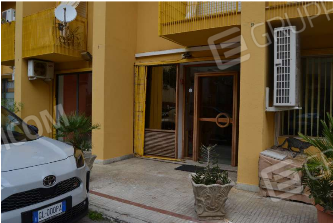
Fotografia 6 – Prospetto via G. Prestisimone n. 25
