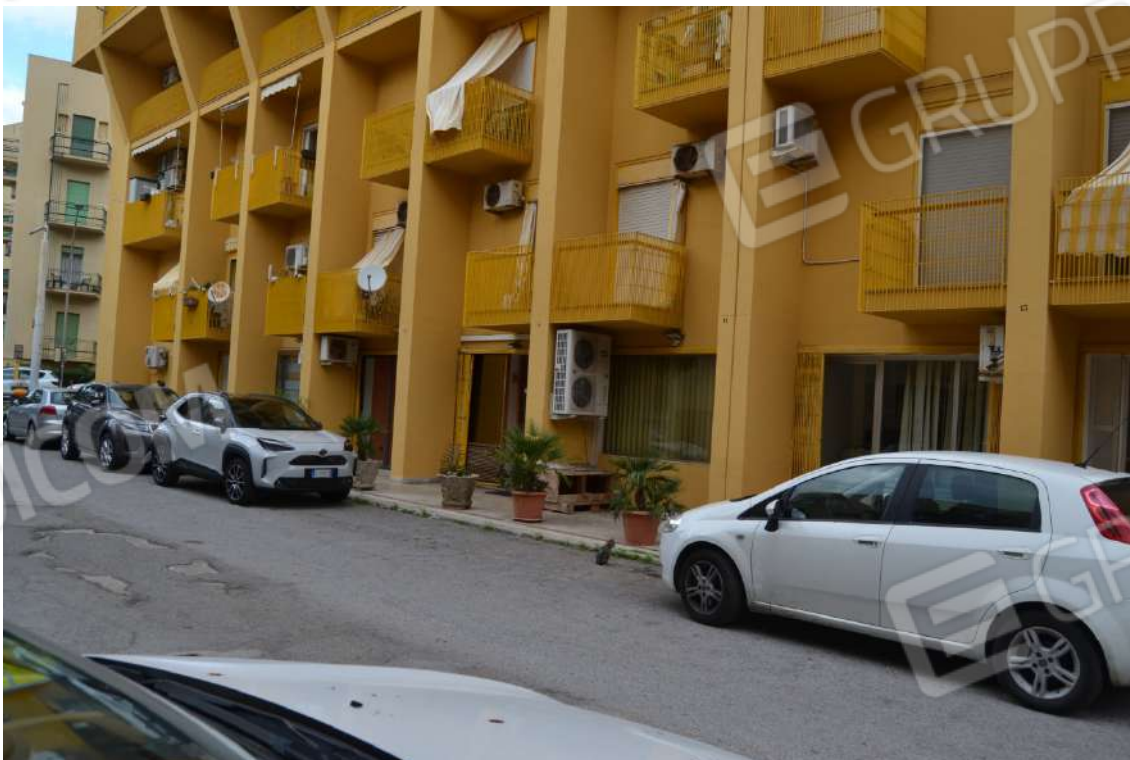
Fotografia 4 – Prospetto via G. Prestisimone n. 25
