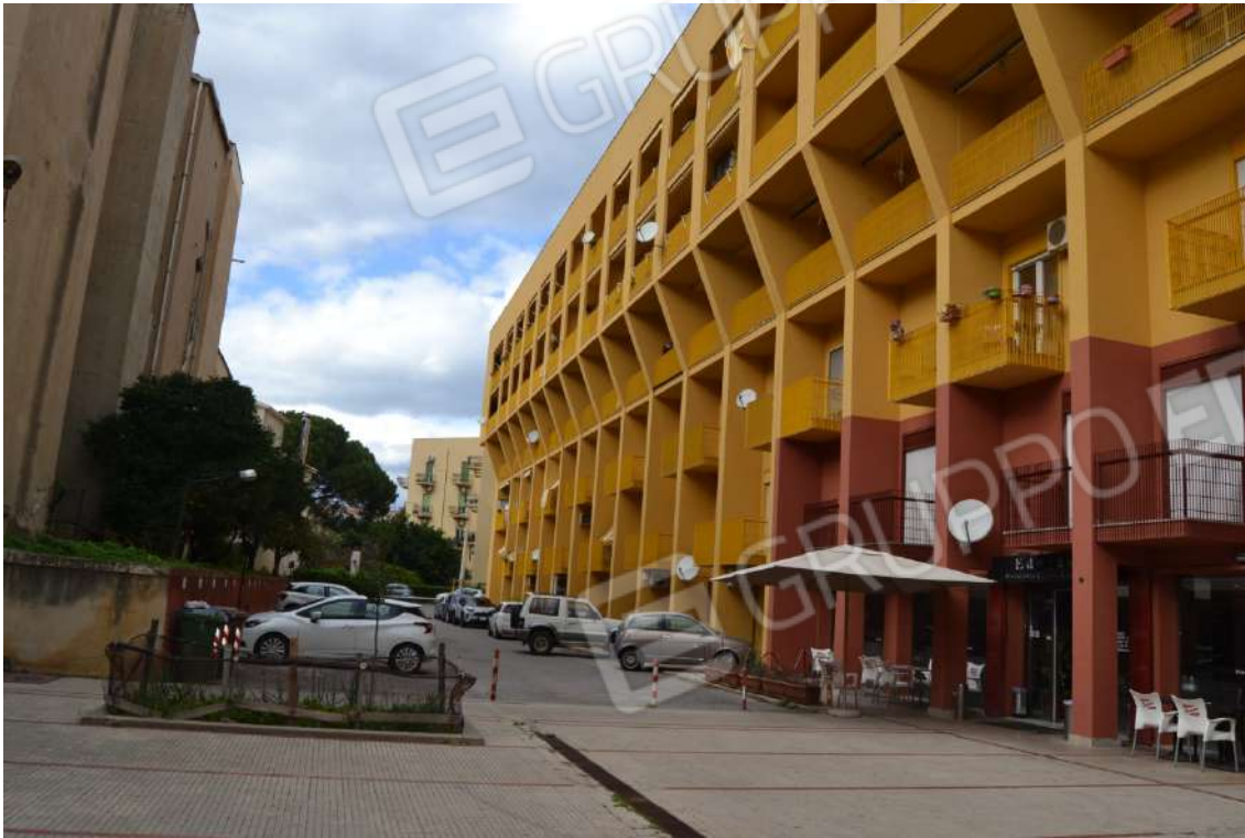
Fotografia 3 – Prospetto via G. Prestisimone n. 25
