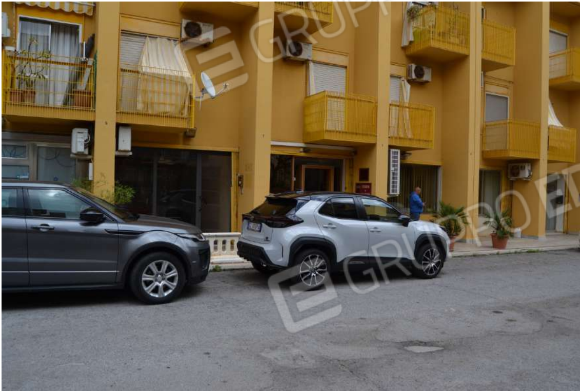
Fotografia 5 – Prospetto via G. Prestisimone n. 25
