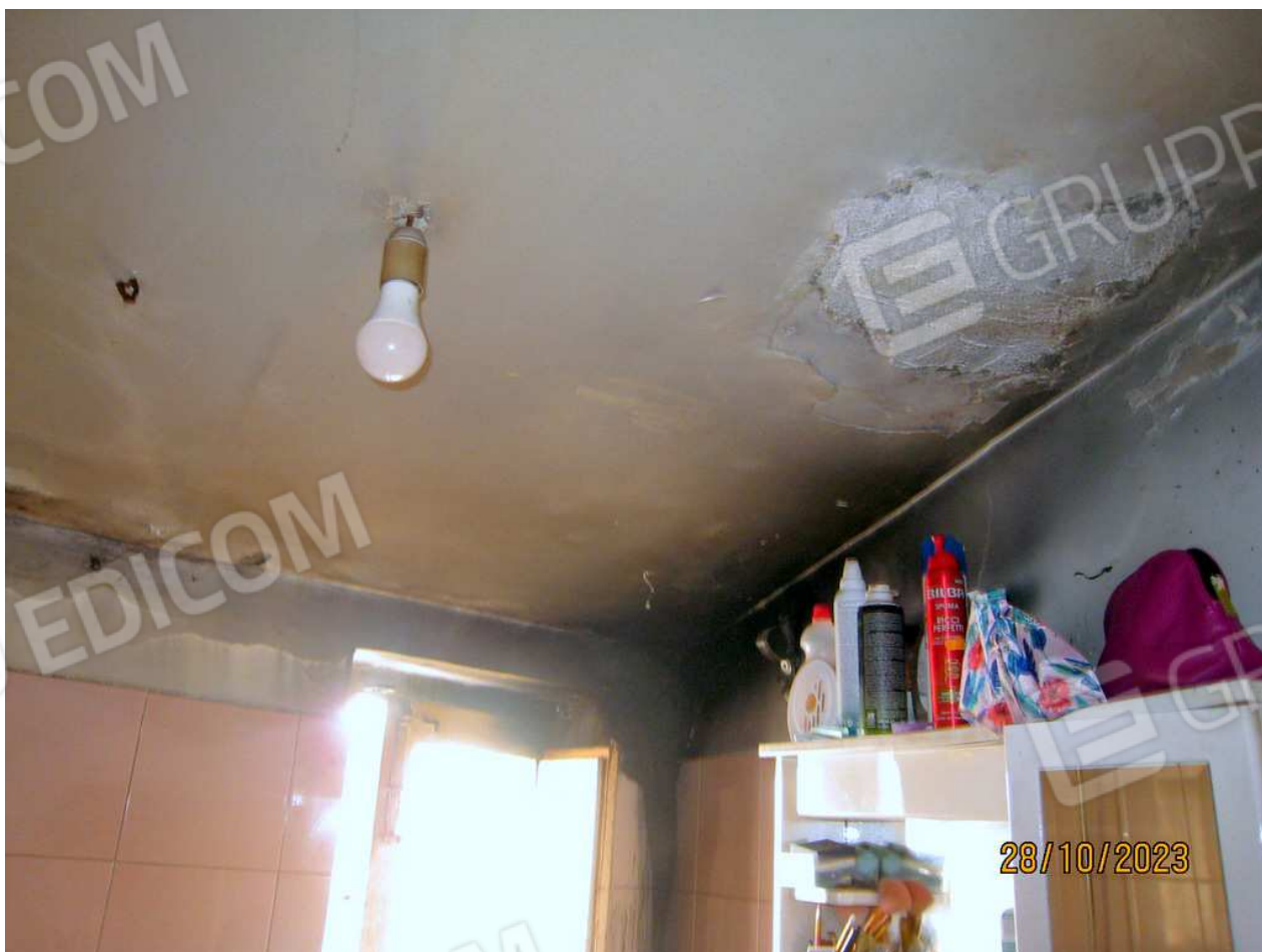
Foto n. 65. Dettaglio del tetto e delle pareti del w.c.
