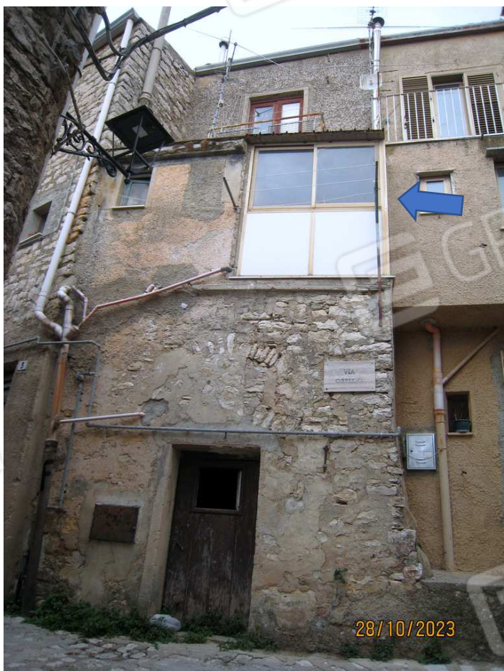
Foto n. 46-47. Le frecce indicano la chiusura abusiva del terrazzino con struttura in metallo, pannelli e vetri.
