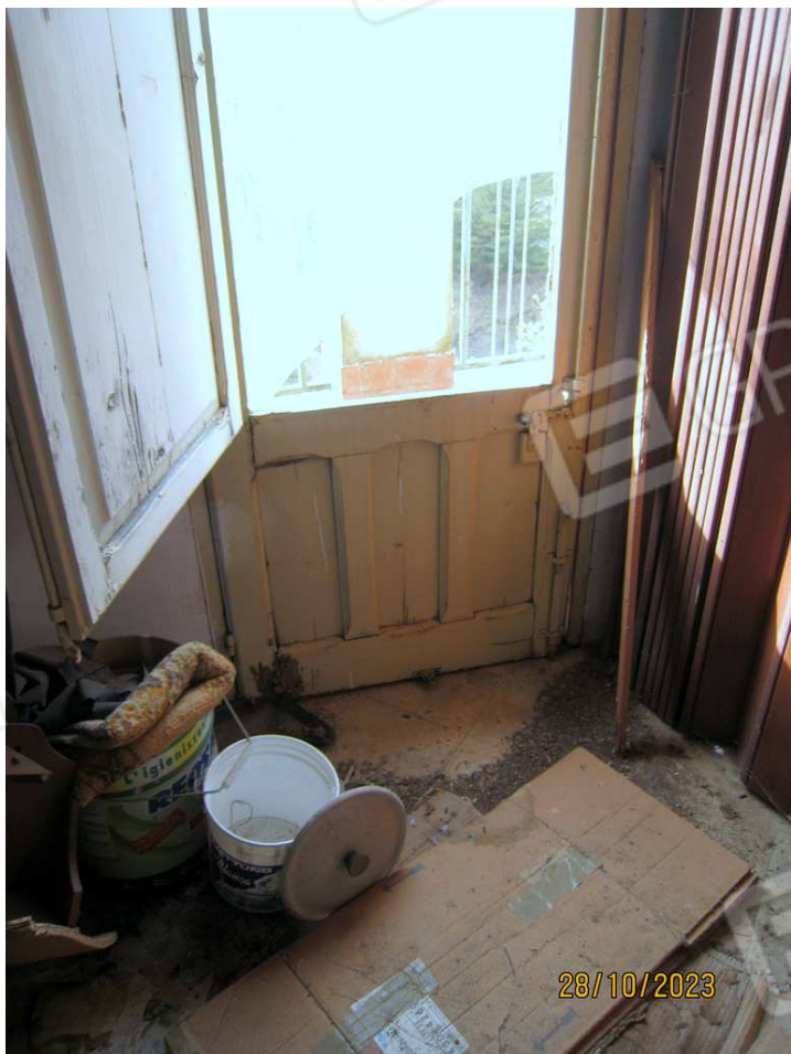
Foto n. 37. L'infisso di accesso al terrazzino è in cattive condizioni. Foto n. 38-39 Il terrazzino che si affaccia su Via Stesicoro ha le mattonelle consumate.
