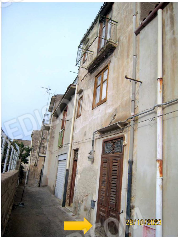
Foto n. 2-4. Il prospetto su Via Stesicoro con il dettaglio dell'umidità ascendente nella parte basamentale e del balcone crollato al secondo piano.
