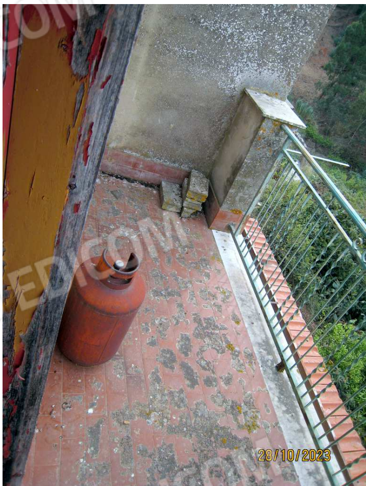
Foto n. 37. L'infisso di accesso al terrazzino è in cattive condizioni. Foto n. 38-39 Il terrazzino che si affaccia su Via Stesicoro ha le mattonelle consumate.
