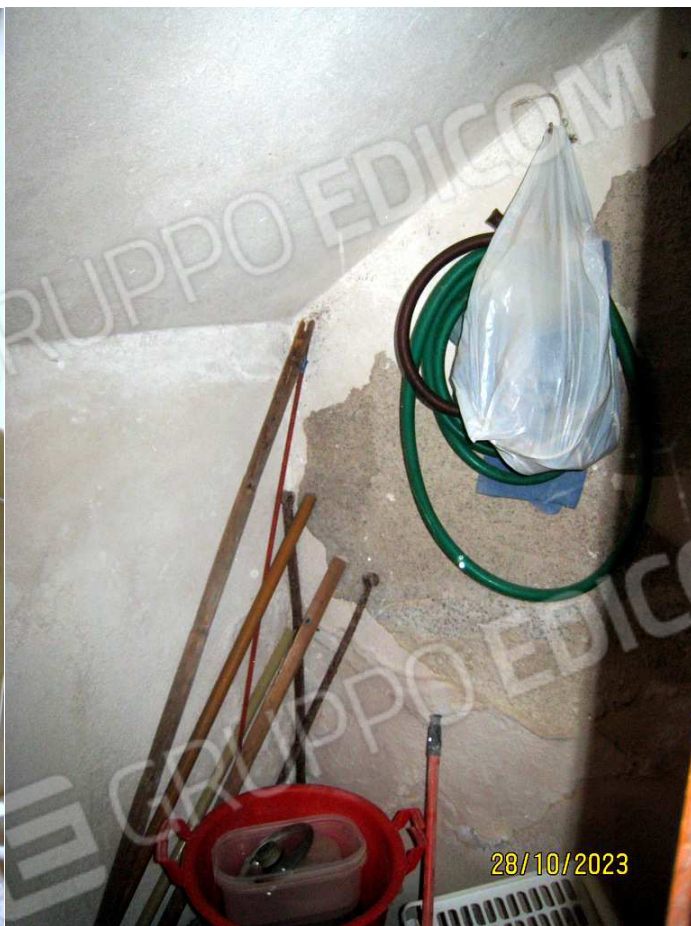
Foto n. 12. Il ripostiglio nel sotto scala del P.T.
