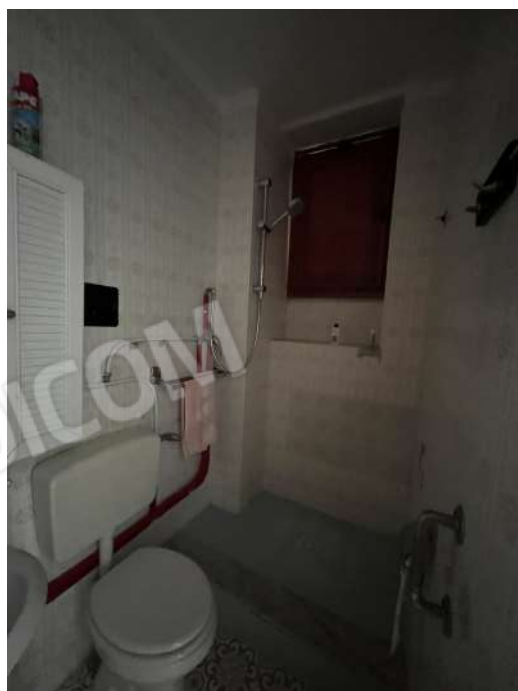
Foto 19 - Servizio igienico (wc 2)
