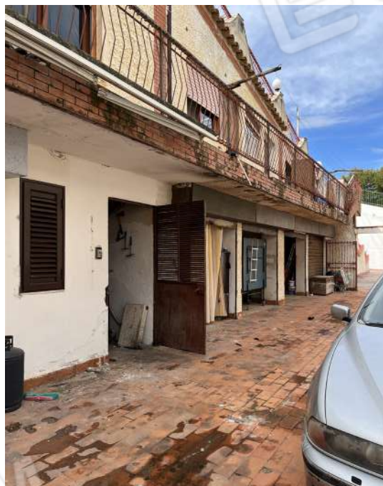
Foto 33 - Porta di accesso al locale tecnico
