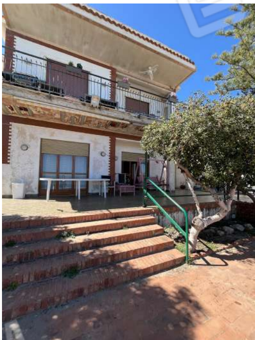
Foto 9 - Fabbricato in cui, al piano terra, è presente il Corpo a
