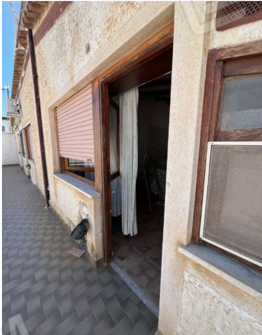
Foto 45 - Accesso al corpo g
