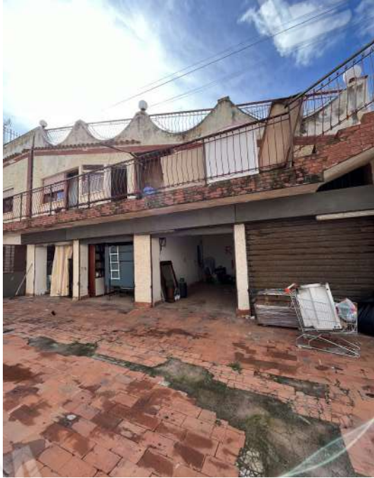
Foto 37 - Fabbricato in cui è sito il Corpo d
