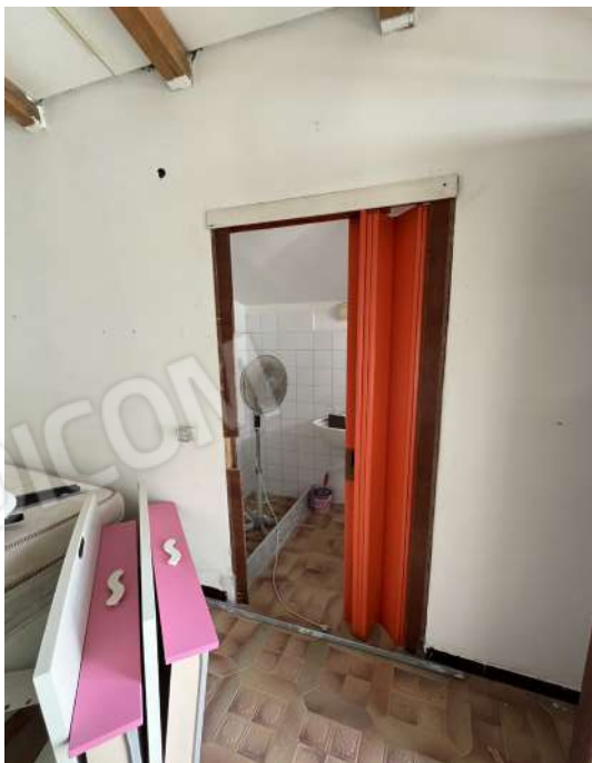
Foto 47 - Accesso al wc
