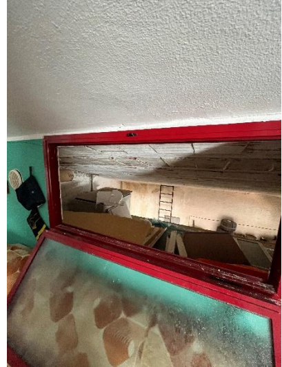
Foto 3 – Finestra su sottotetto
