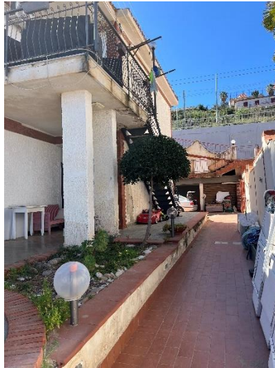
Foto 5- Prospetto lato Ovest della villetta bifamiliare
