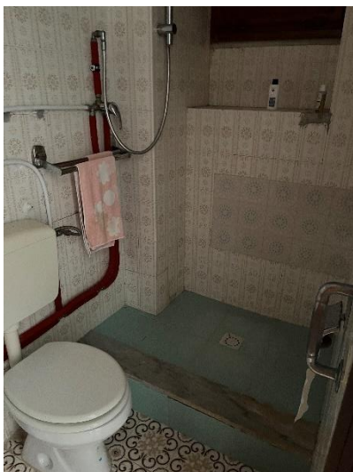
Foto 14- Servizio igienico (wc 2)
