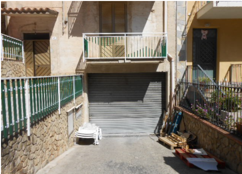
1. La rampa di accesso al magazzino, in fondo la saracinesca. Via Antonello Gagini n. 43
