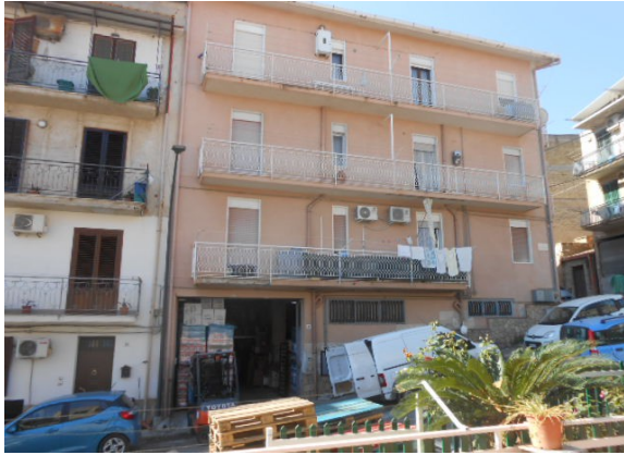
2. Il prospetto col balcone prospiciente Via Gagini
