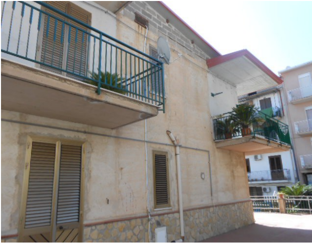
2. Prospetto ovest, sulla corte esclusiva prospiciente Via Giardinello
