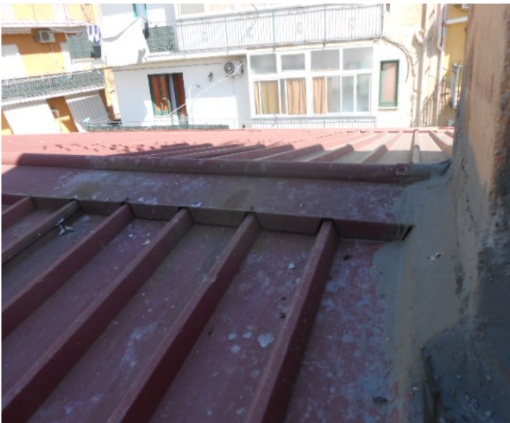
4. Il colmo del tetto e le due falde inclinate. A destra si intravede la parete esterna del torrino scala con lo stipite della porta per la ispezione e manutenzione della copertura.
