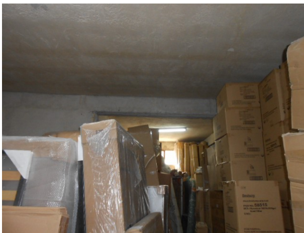
5. Interno del magazzino. In fondo si nota la luce proveniente dalla saracinesca sul prospetto sud con la rampa prospiciente Via Antonello Gagini n. 43
