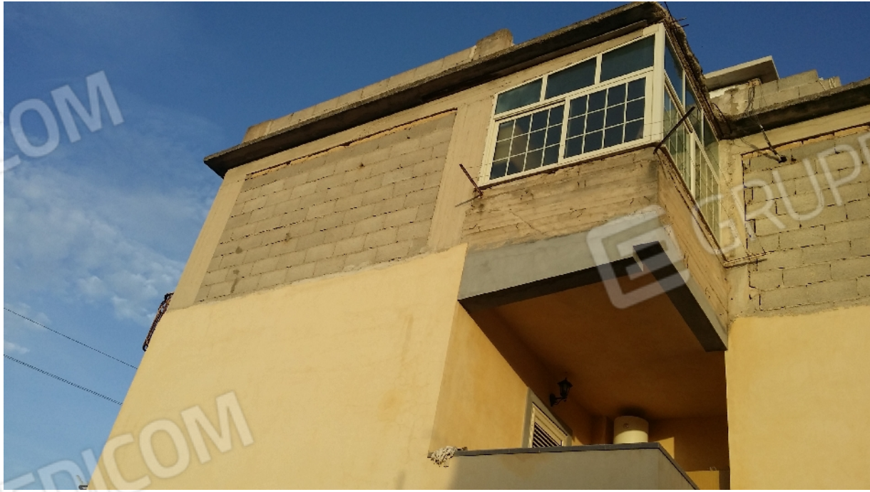
Vista prospetto Ovest
