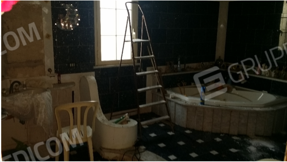
Vista bagno principale
