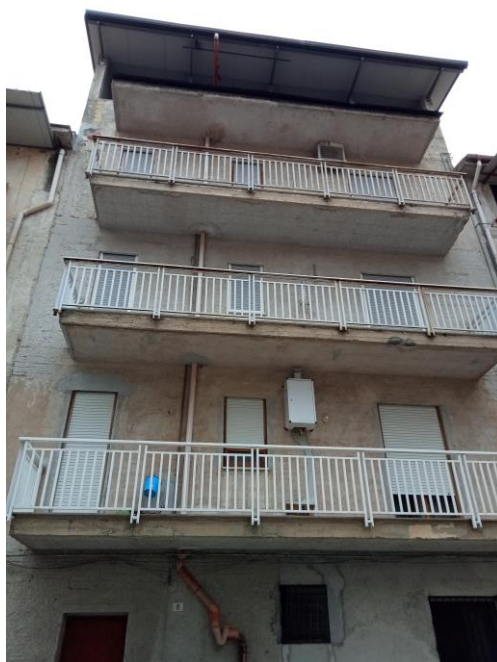
Foto 3: "Prospetto secondario intero fabbricato della Via Tindari"
