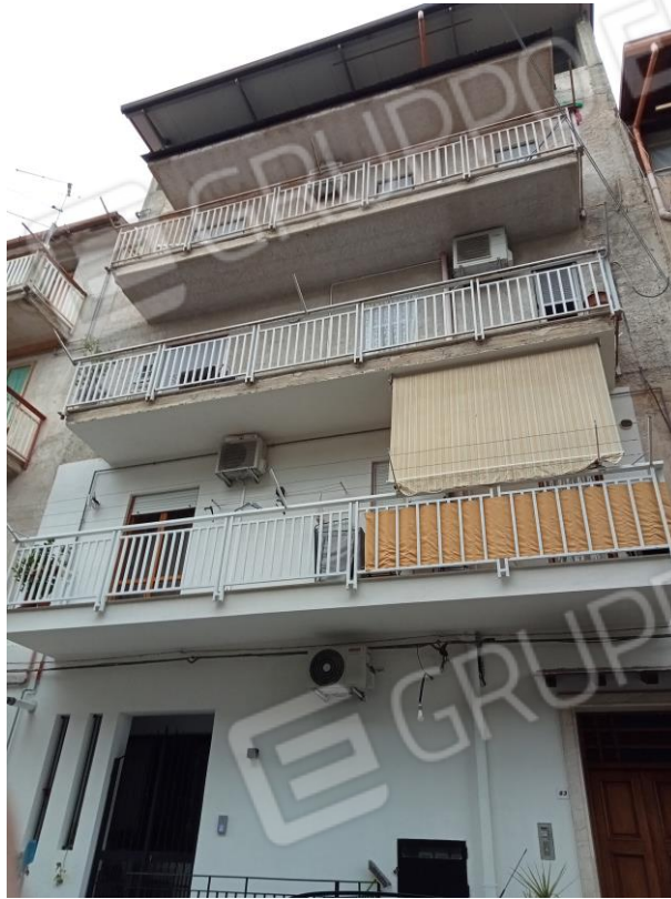
Foto 1: "Prospetto principale intero fabbricato della Via Eraclea Minoa"
