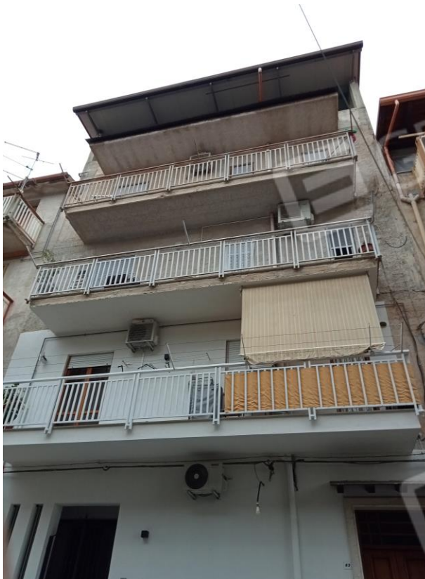
Foto 2: "Prospetto principale intero fabbricato della Via Eraclea Minoa"
