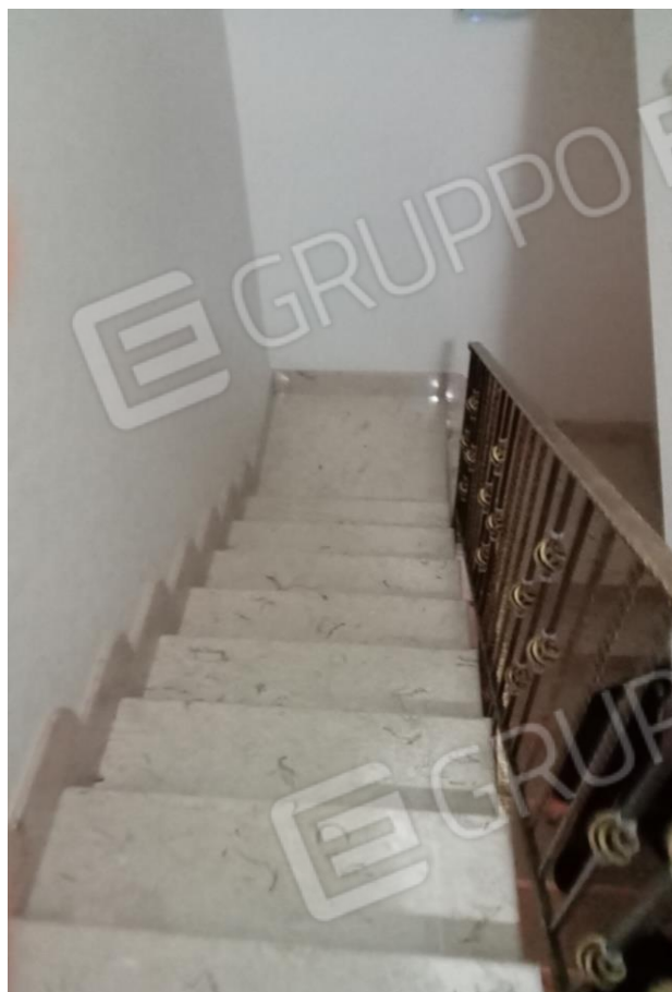
Foto 5: "Corpo scala fabbricato"
