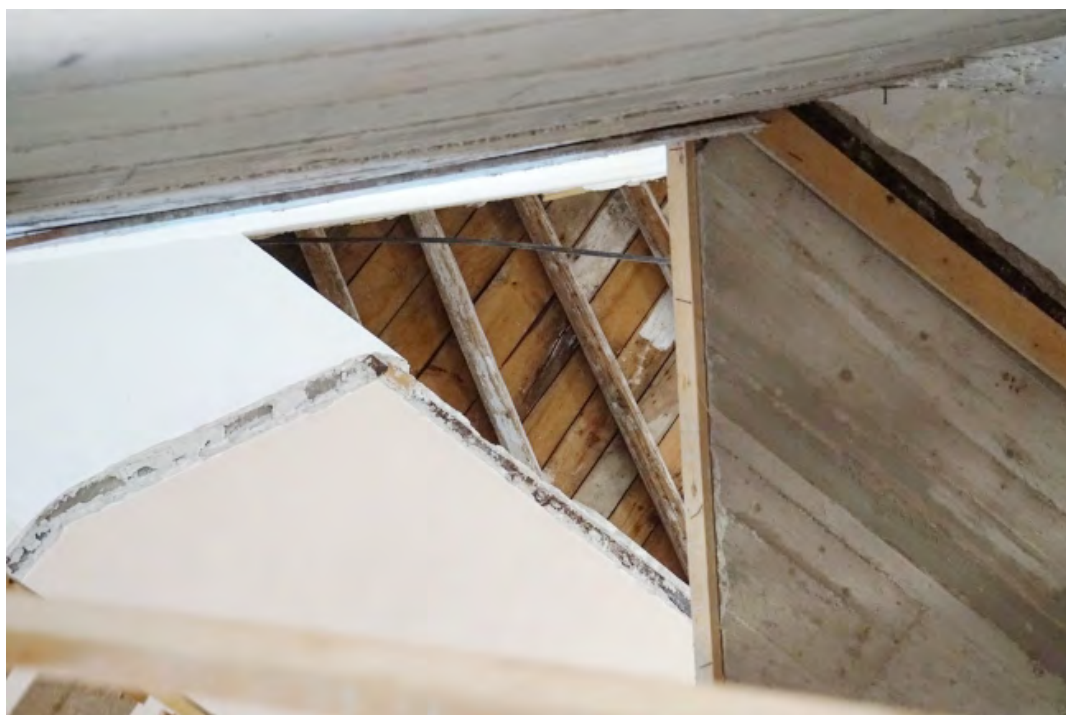
visuale dal vano scala
