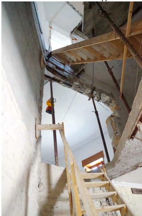
muro portante parzialmente demolito
