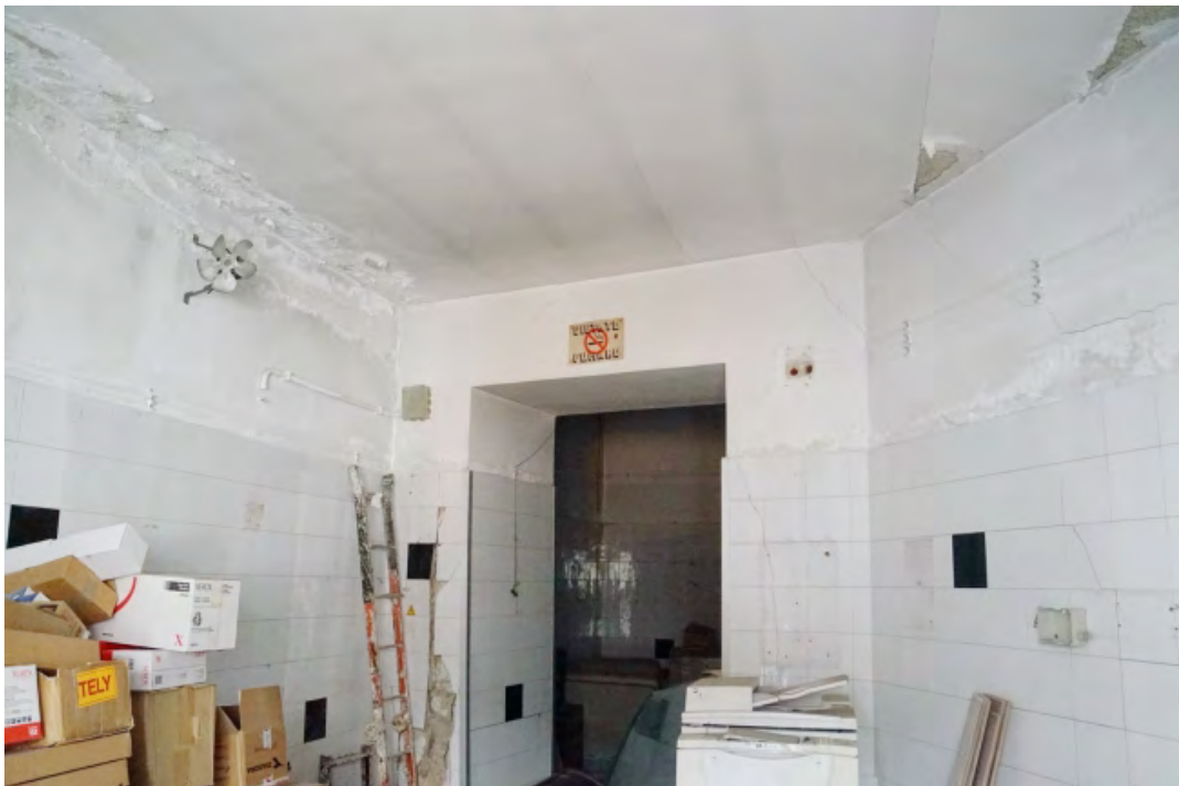
vano di accesso
