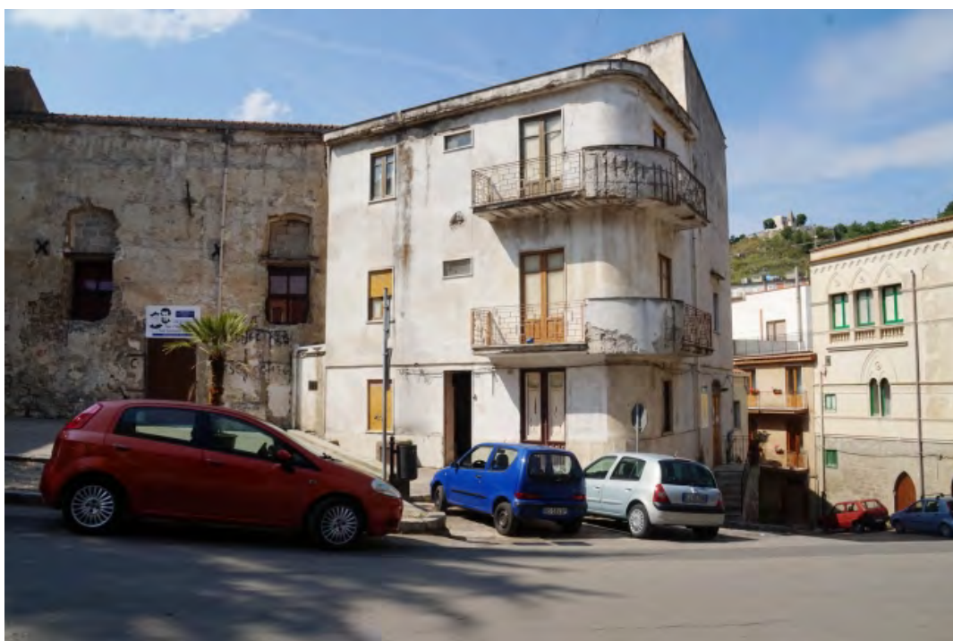
Abitazione cielo/terra - foto del prospetto attuale
