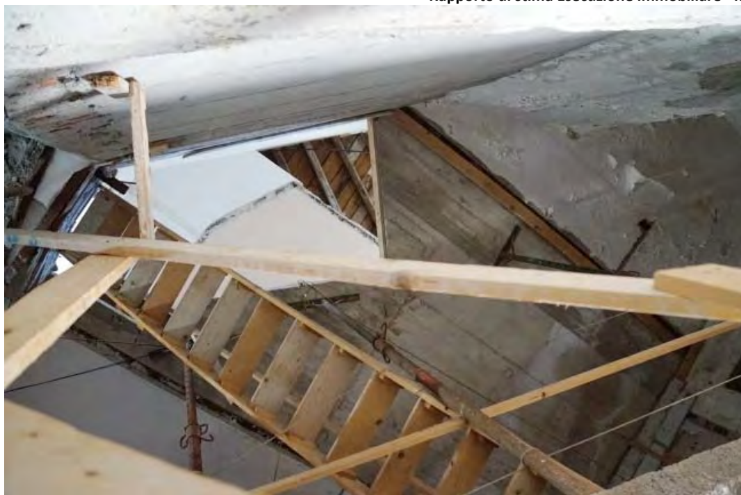
visuale dal vano scala
