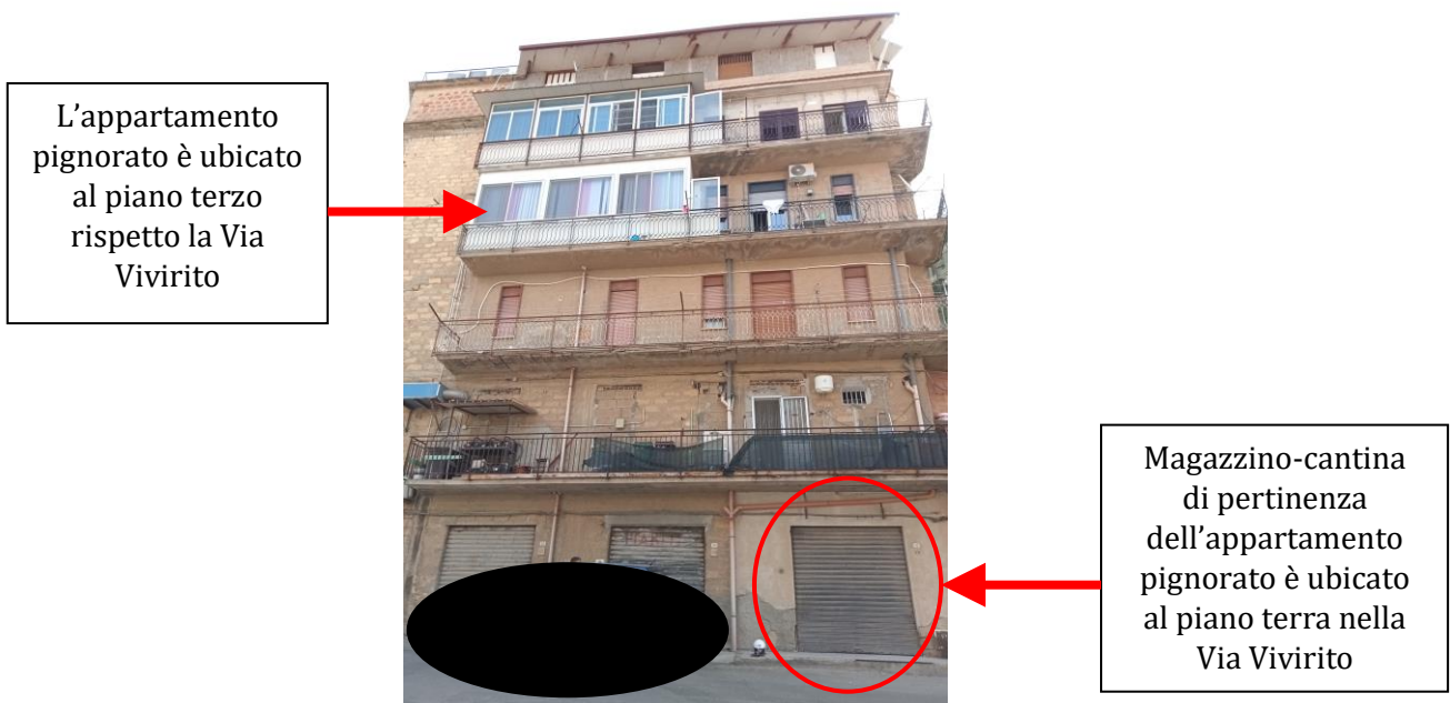
Foto 3: "Prospetto secondario intero fabbricato della Via Vivirito"
