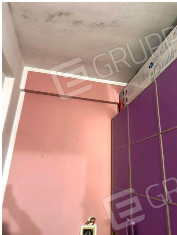
**Abitazione - Ripostiglio adibito a camera da letto di singola - evidenti segni di umidità da risalita e condensa sul soffitto - Zone da demolire (cfr planimetria)**
