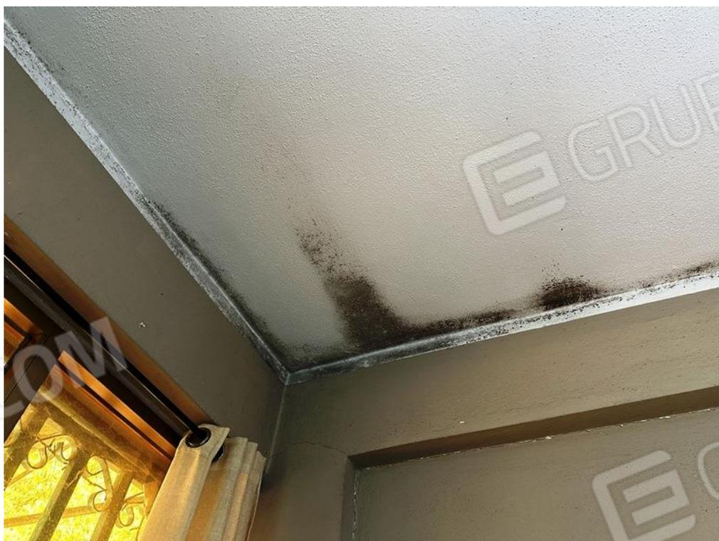
**Particolari - evidenti segni di muffa/condensa sul soffitto e lesioni sulla muratura**
