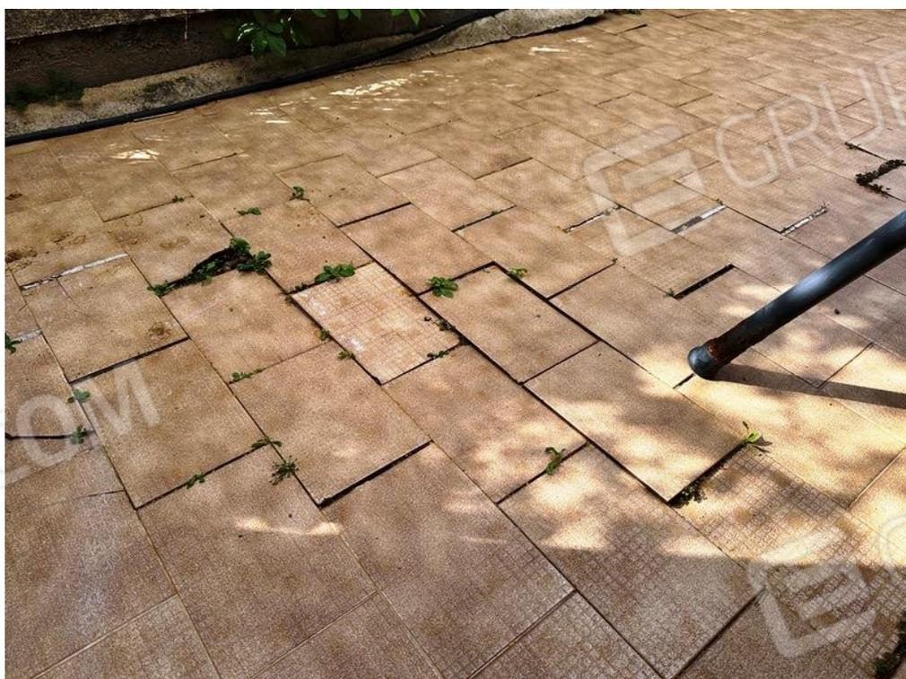
**Particolari - Pavimentazione esterna con segni di distacco e lesioni**
