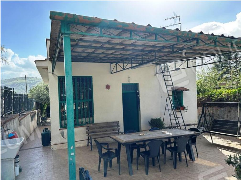
**Accesso dalla corte esclusiva dell'unità immobiliare – prospetto principale – Tettoia con copertura in fibrocemento da dismettere e rimodulare.**
