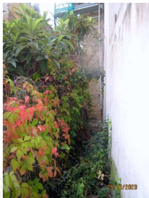
Foto n. 14. Il passetto o corte pertinenziale del fabbricato, confinante al terreno pignorato, distinto con la p.lla 482 ed appartenente a terzi.
