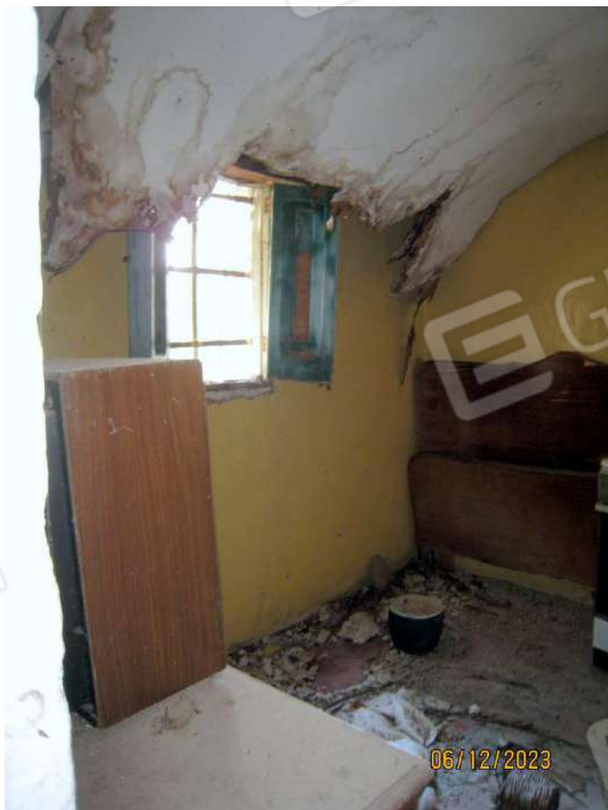
La seconda stanza del piccolo fabbricato. Il tetto è quasi completamente crollato. Le infiltrazioni d'acqua sono palesi.
