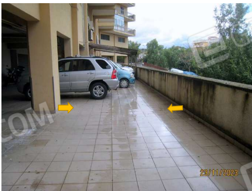
Foto n. 21-23. Il parcheggio, vincolato in favore del Comune di Corleone e dato in uso ai singoli condomini in quota parte, si svolge dal filo dei pilastri verso il muretto parapetto e lungo quasi tutto il retro prospetto dello stabile.
