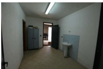
Foto 11 – Capannone area spogliatoi
