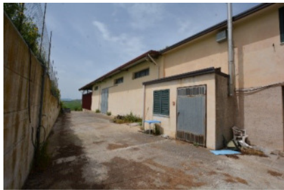
Foto 20– Capannone prospetto SUD - Locale caldaia e area di pertinenza
