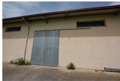
Foto 21– Capannone prospetto SUD - Ingresso carrabile
