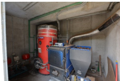
Foto 24 – Capannone - Locale caldaia
