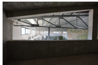
Foto 37 - Capannone – solaio di copertura area uffici (vista verso parete Ovest)
