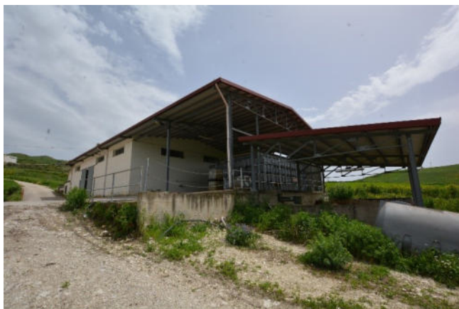
Foto 3 - Capannone Fg. 30, p.lla 630 sub. 1 e 2
