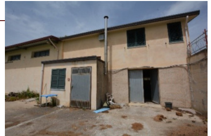
Foto 19 – Capannone prospetto SUD - Locale caldaia e porticato/deposito
