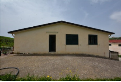
Foto 29 - Ingresso alloggio da p.lla 629
