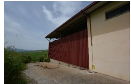
Foto 22– Capannone prospetto SUD - Tettoia (1) con parete in lamiera
