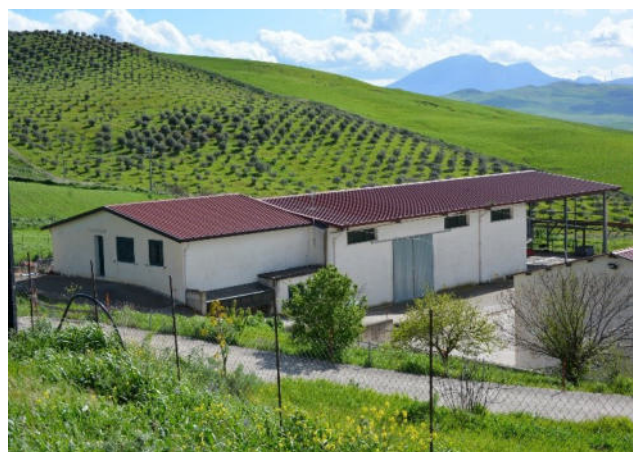
Foto 2 - Capannone Fg. 30, p.lla 630 sub. 1 e 2
