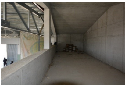
Foto 36 - Capannone – solaio di copertura area uffici (vista verso parete Nord)
