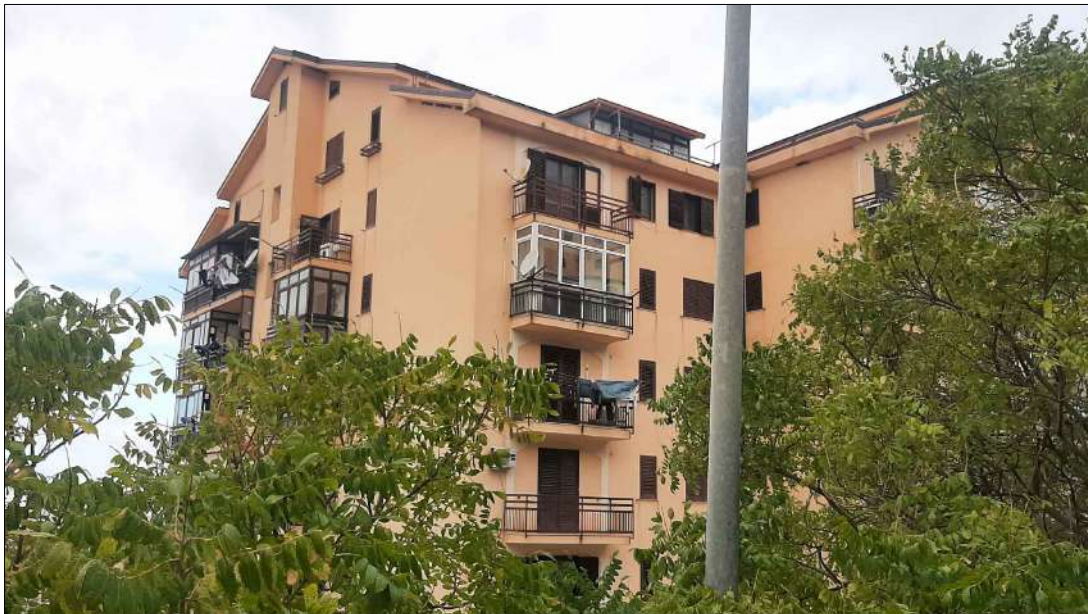
Prospetto laterale edificio
