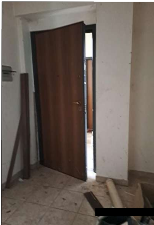
Porta ingresso appartamento
