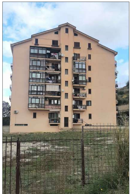
Prospetto retrostante - edificio C
