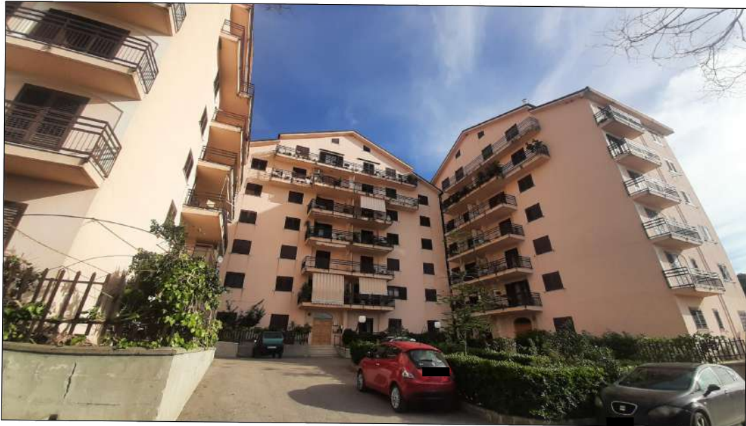
Prospetto - complesso dei tre edifici
