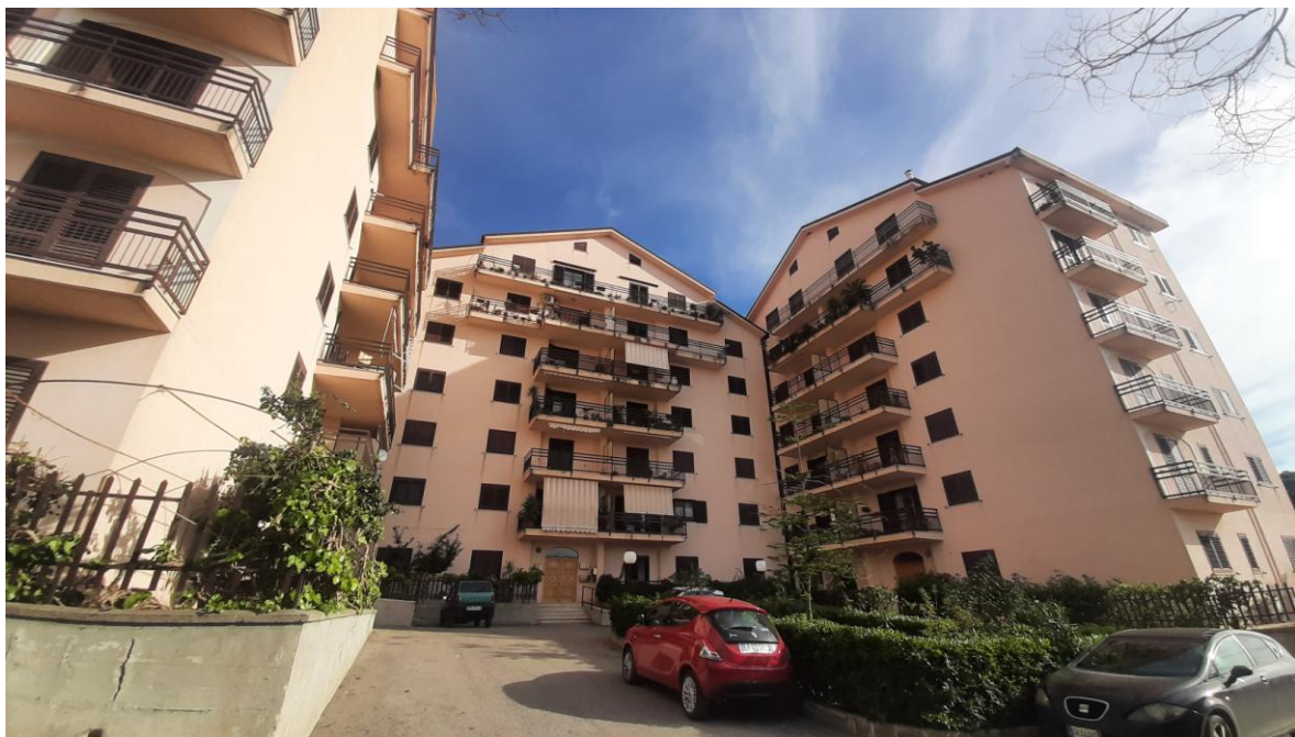
Foto complesso degli edifici
