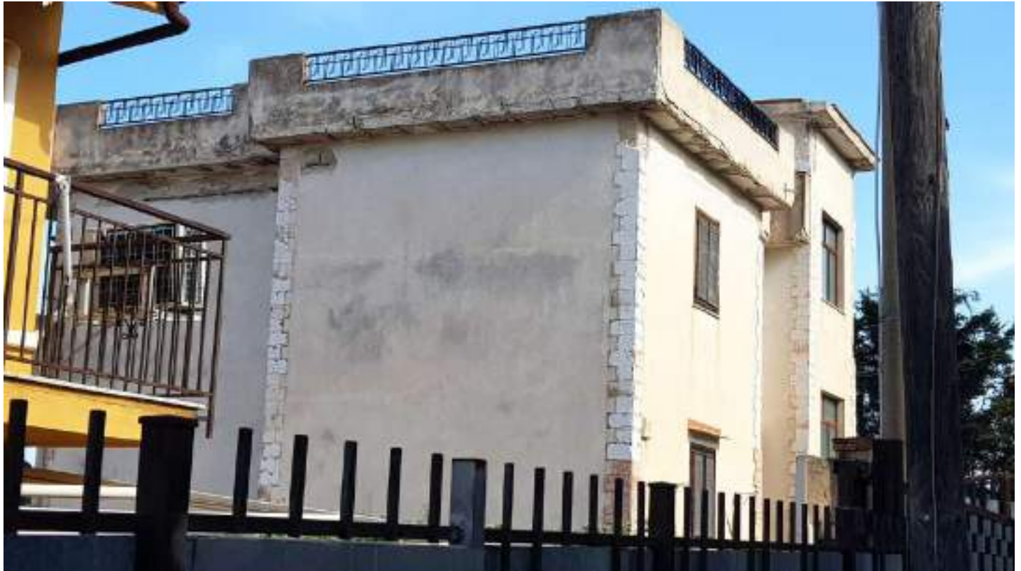
Foto n. 2. Prospetto Ovest a fine lavori.
