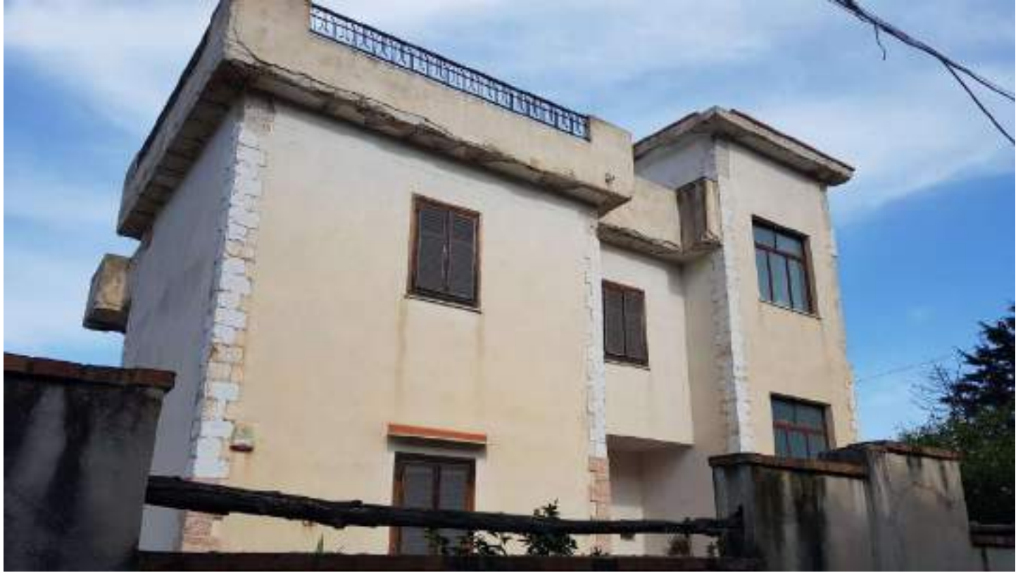
Foto n. 1. Prospetto Sud, lato ingresso, a fine lavori.
