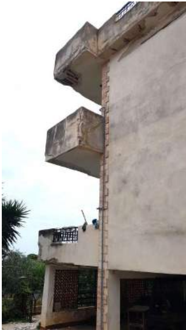
Foto n. 5. Dettaglio della rimanente porzione Ovest del prospetto, continuazione della foto 4.
