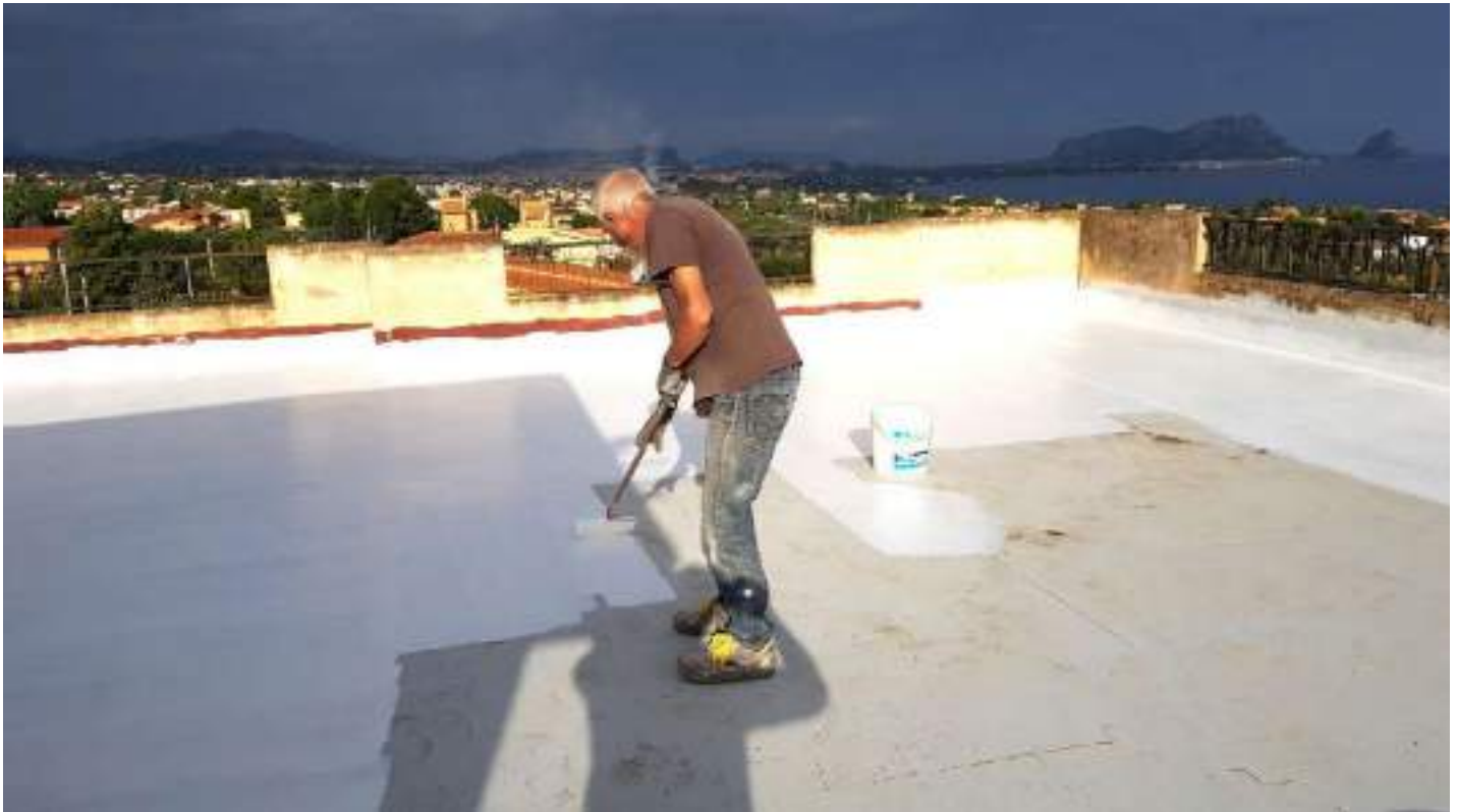
Foto n. 14. Posa in opera della guaina impermeabilizzante (lato Ovest del terrazzo).
