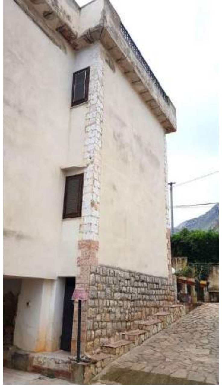
Foto n. 4. Dettaglio del prospetto Ovest.
