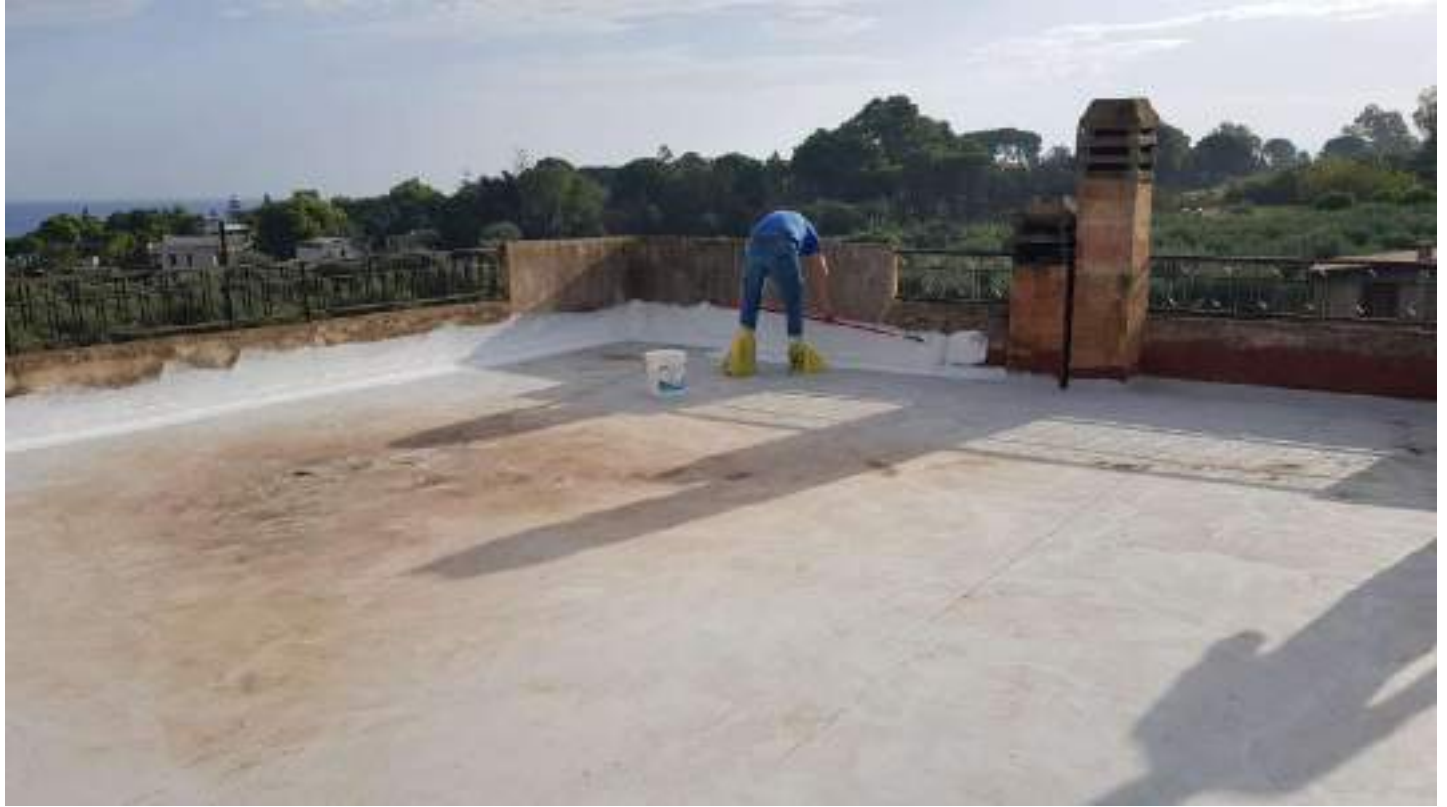
Foto n. 15. Posa in opera della guaina impermeabilizzante (lato Est del terrazzo).
