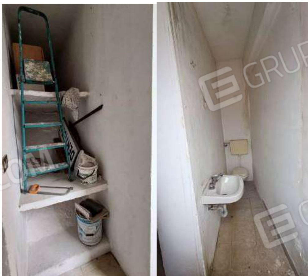
FOTO 8 – A sinistra anti-wc (3), a destra wc (4)
