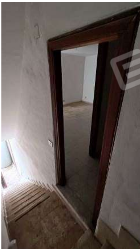
FOTO 4 – Ingresso dal vano scala interno
