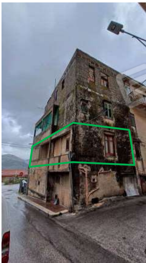
FOTO 2 – Prospetto sud-ovest e sud-est della palazzina
