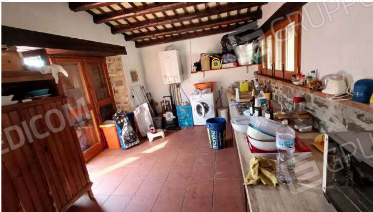
FOTO 28 – Locale cucina esterna (14), particolare della caldaia a servizio della villa
