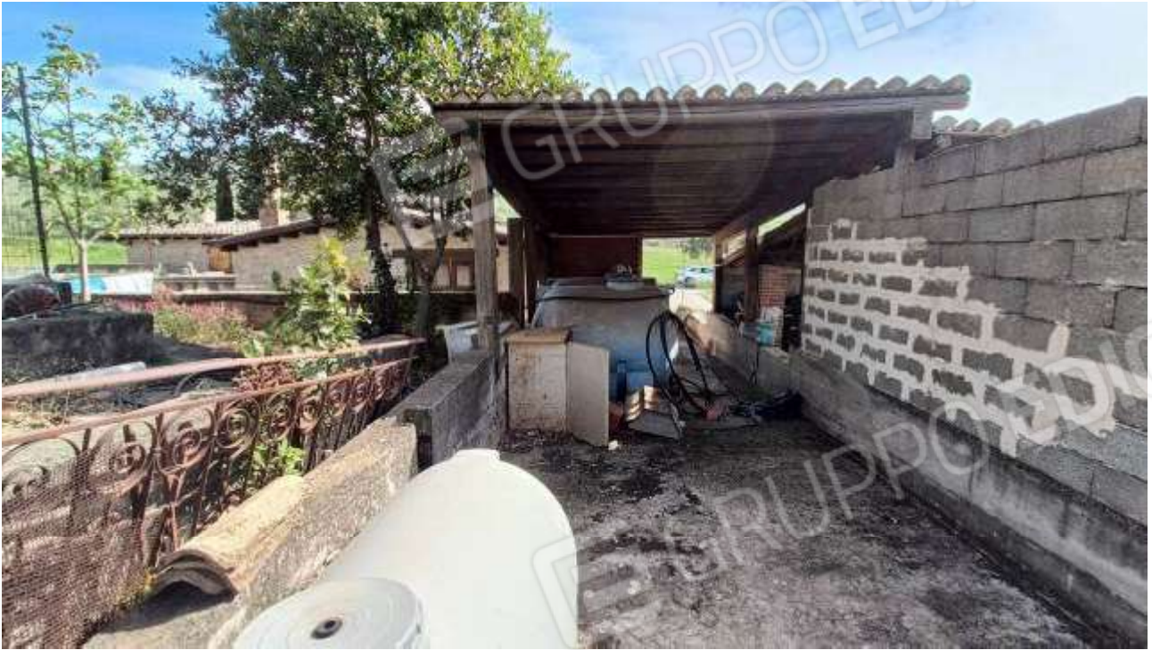
FOTO 5 – Tettoia B (riserva idrica)
