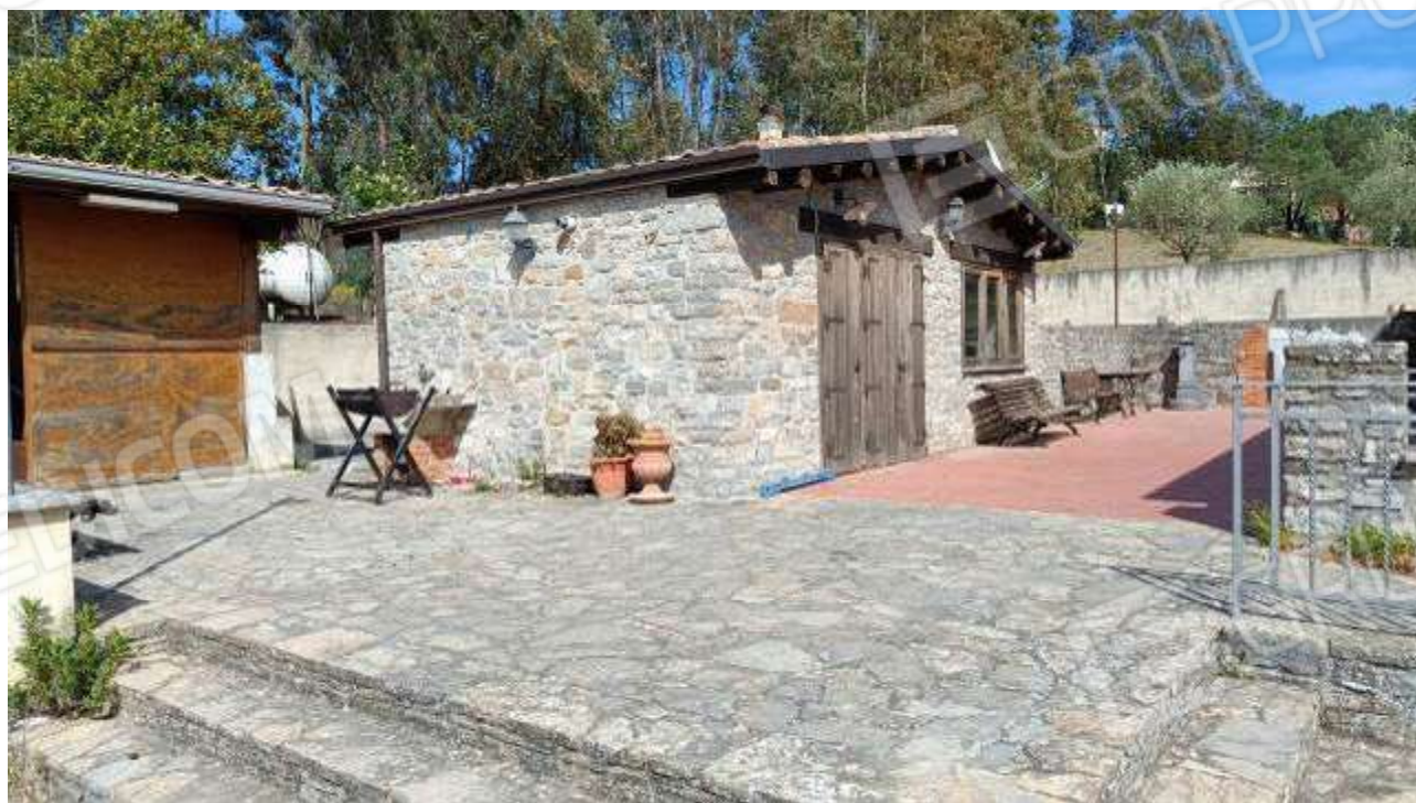
FOTO 4 – Prospetti sud e ovest cucina esterna, particolare del serbatoio GPL
