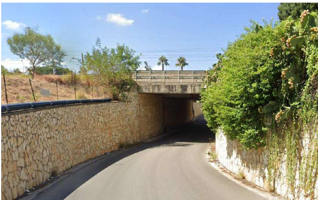
Foto 3 – Sottopasso di collegamento al mare
